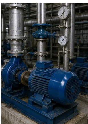
照片 №15. 保养后设备正常运行
