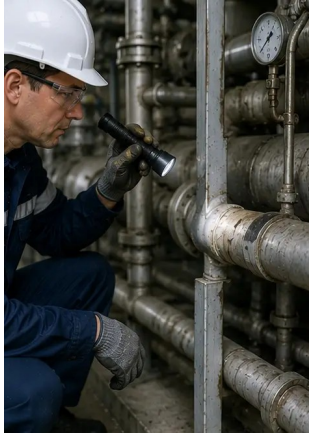
照片 №9. 按保养计划完成管道检查
