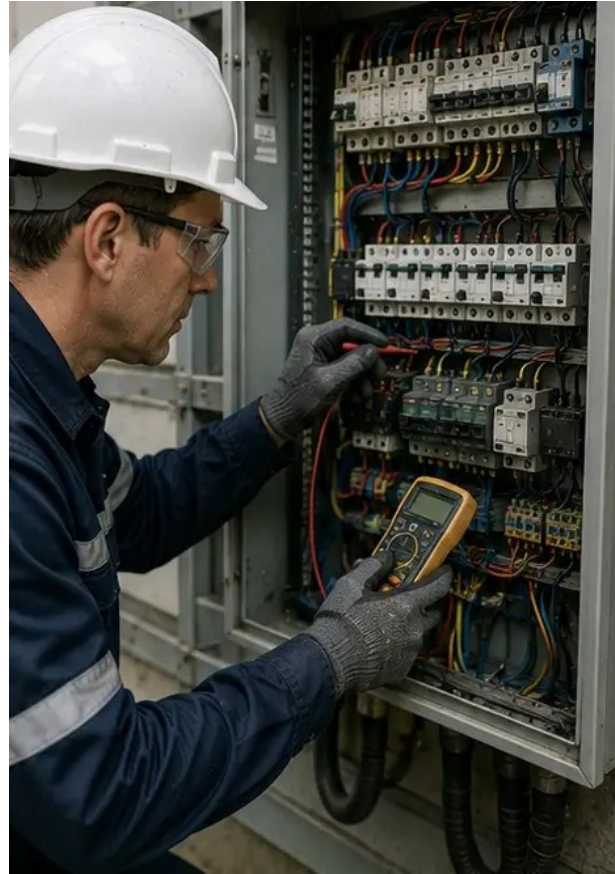
照片 №5. 已进行电气柜检查
