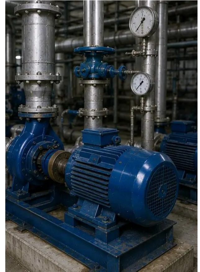
照片 №15. 保养后设备正常运行
