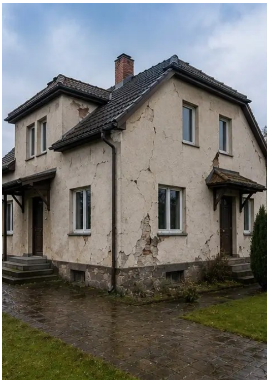
照片 №1 被检物业全貌
