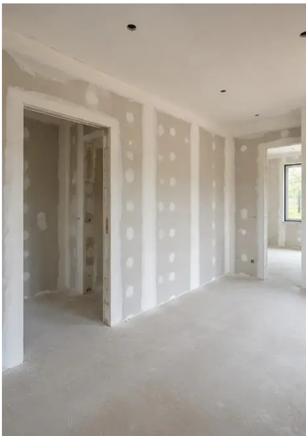
照片 №11 内墙装修工作进行中
