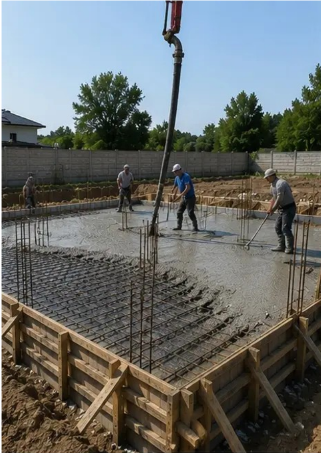
照片 №5 基础构件混凝土浇筑作业
