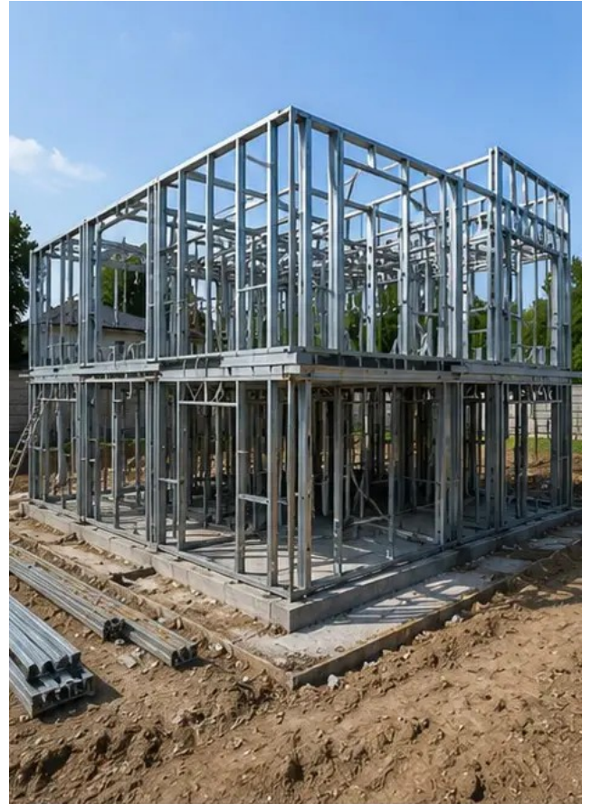
照片 №6 结构框架组装进行中
