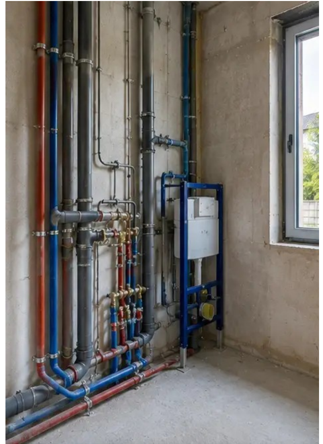
照片 №10 指定区域内管道系统安装完成
