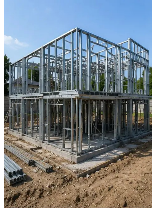
照片 №6 结构框架组装进行中
