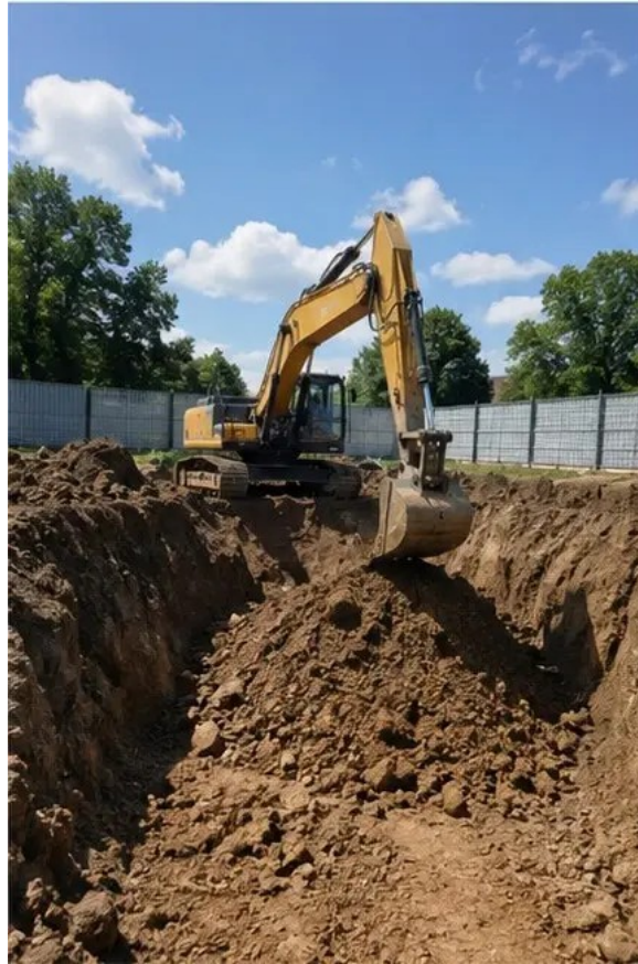
照片 №2 按项目要求进行的开挖工作
