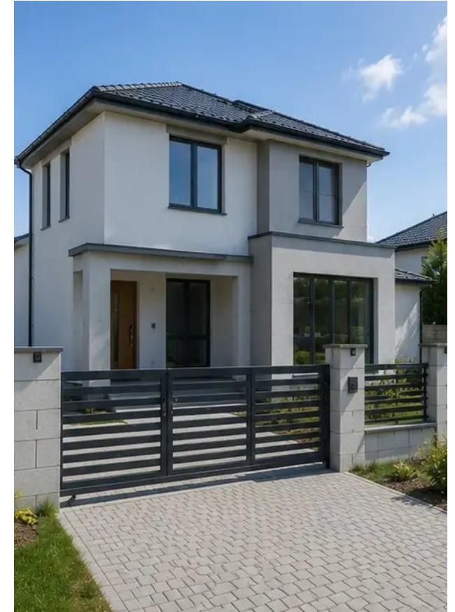
照片 №15 建成后的建筑外观
