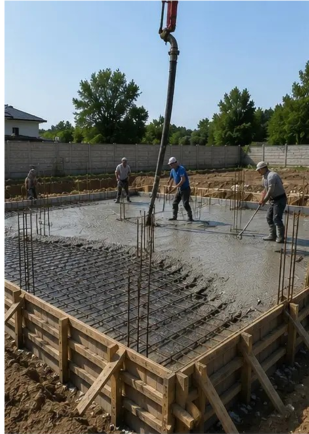
照片 №5 基础构件混凝土浇筑作业
