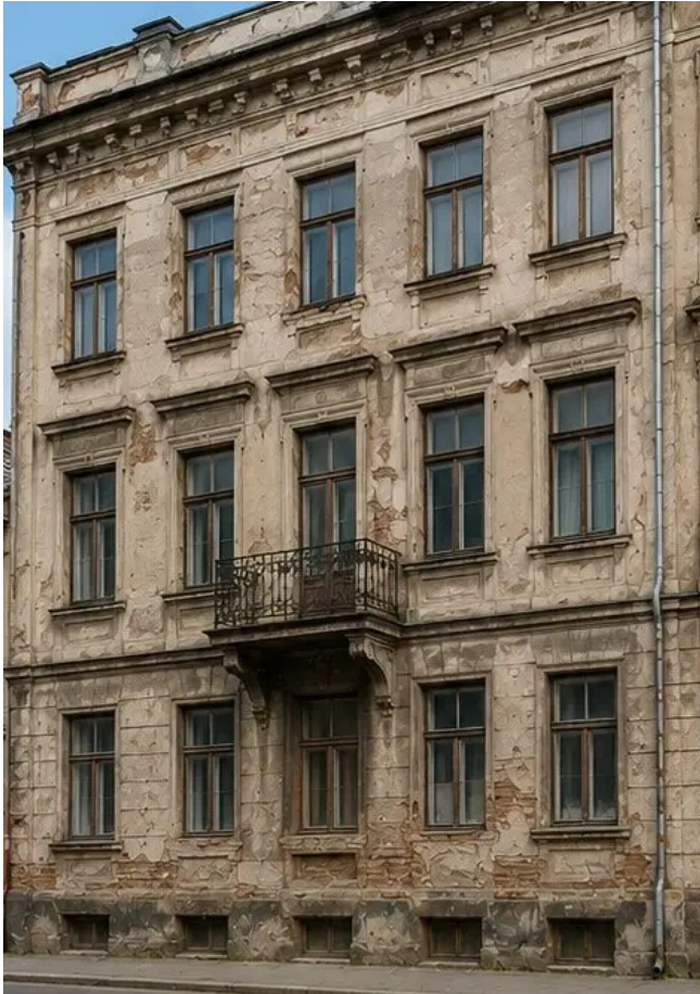
照片 №13 修复前建筑外立面
