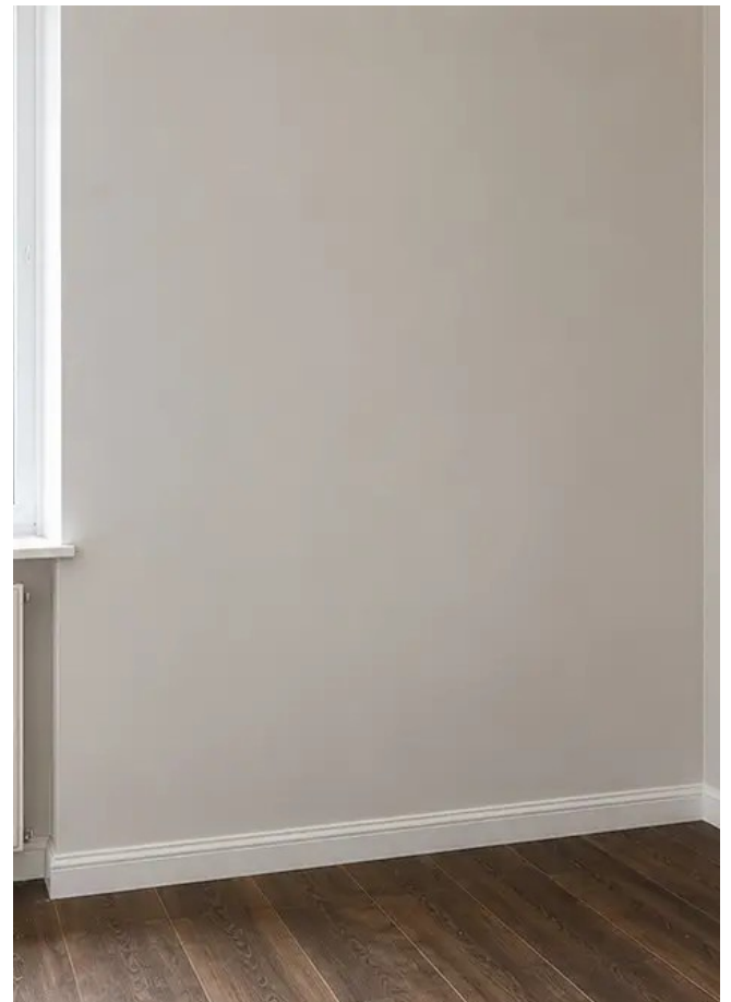
照片 №4 修缮后墙面状况
