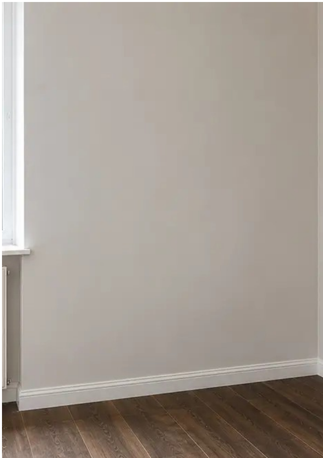
照片 №4 修缮后墙面状况
