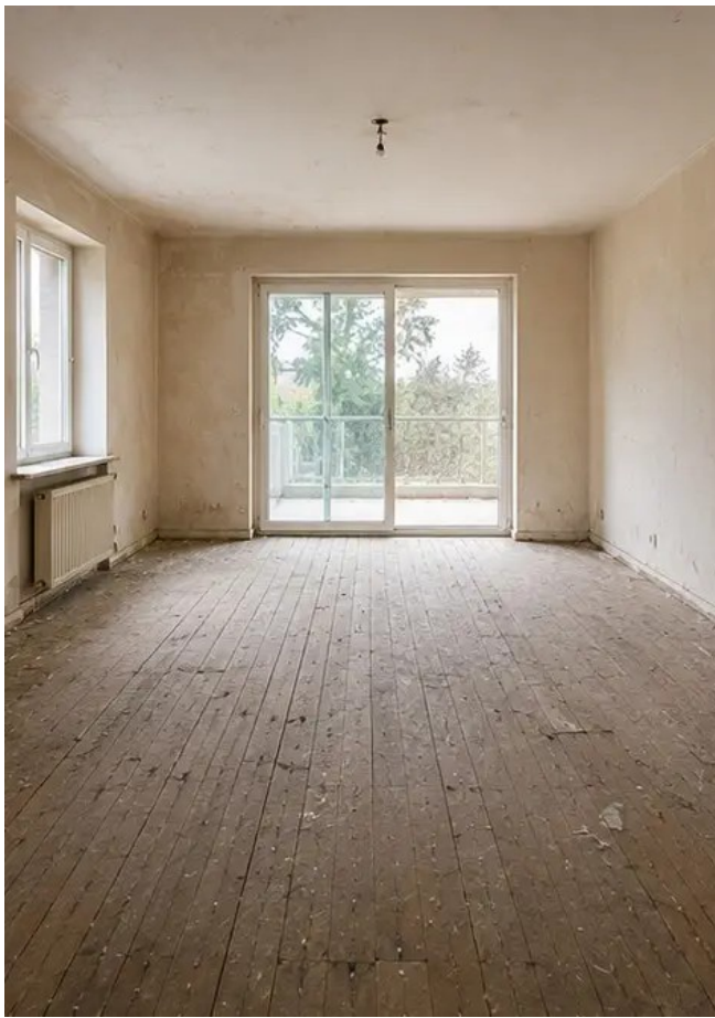
照片 №1 装修前客厅状况
