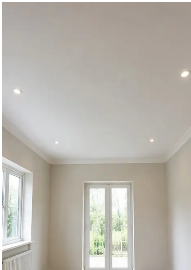
照片 №8 装修后天花板状况
