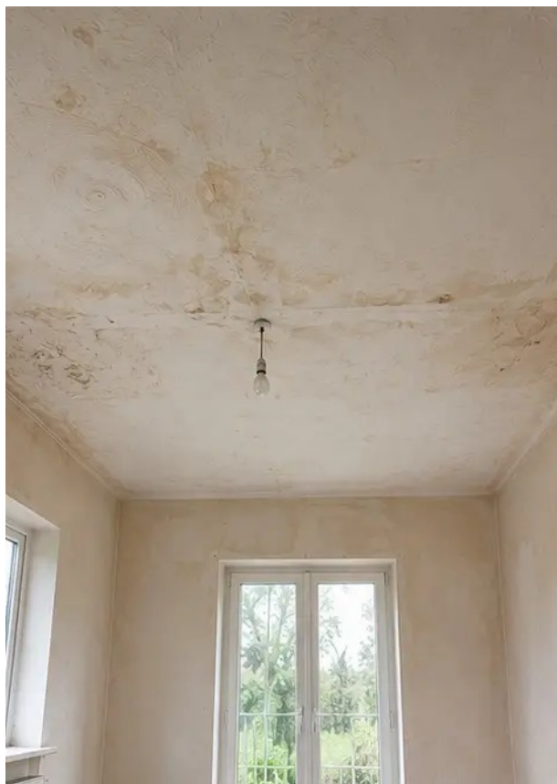
照片 №7 装修前天花板状况
