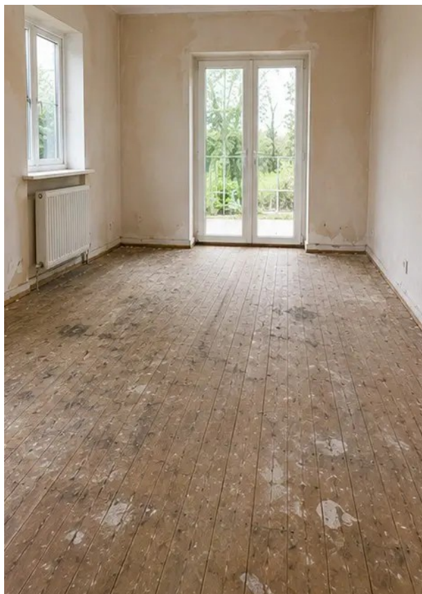
照片 №5 更换前地板状况
