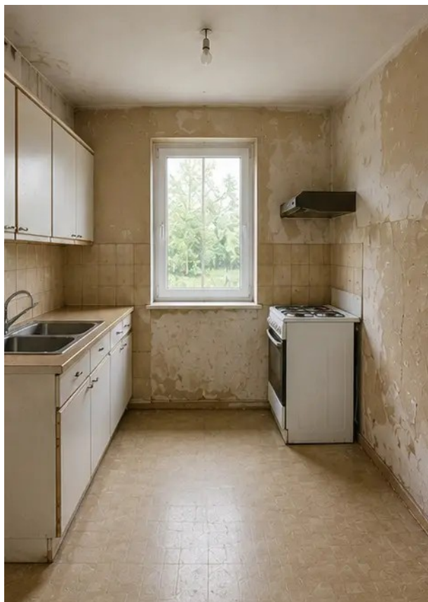
照片 №11 装修前厨房状况
