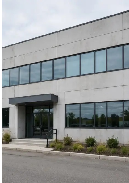
Photo #2. 检查期间前立面状况
