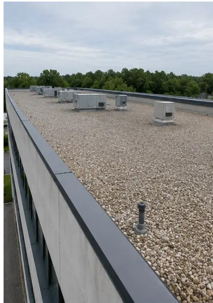
Photo #5. 屋顶状况检查完成
