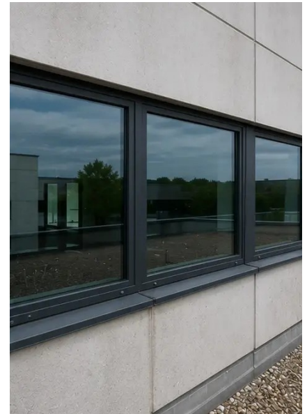
Photo #6. 检查期间记录的窗户状况
