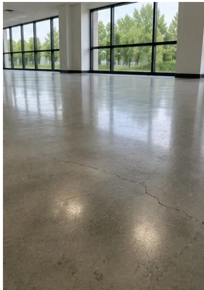
Photo #14. 地面状况已评估并记录
