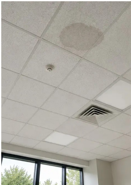
Photo #13. 检查期间记录的吊顶状况
