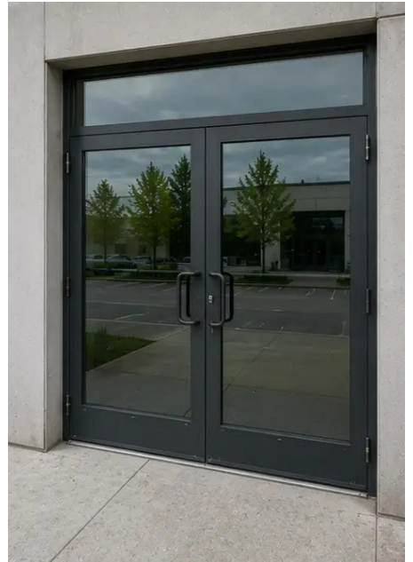
Photo #7. 门状况已检查并记录
