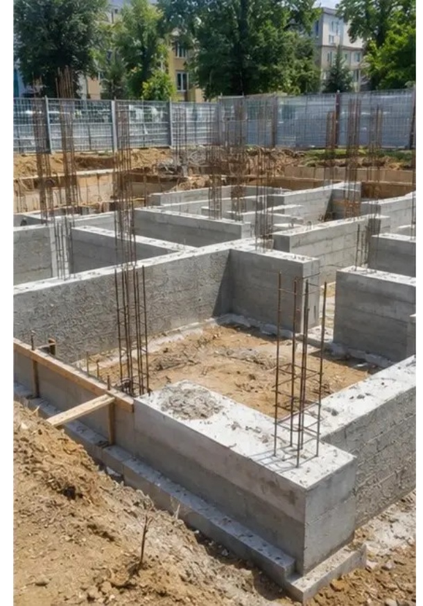
Ảnh số3 Thi công móng đang tiến hành
