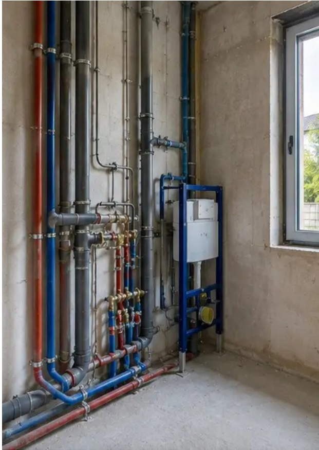
Ảnh số10 Lắp đặt hệ thống ống nước hoàn tất trong khu vực quy định
