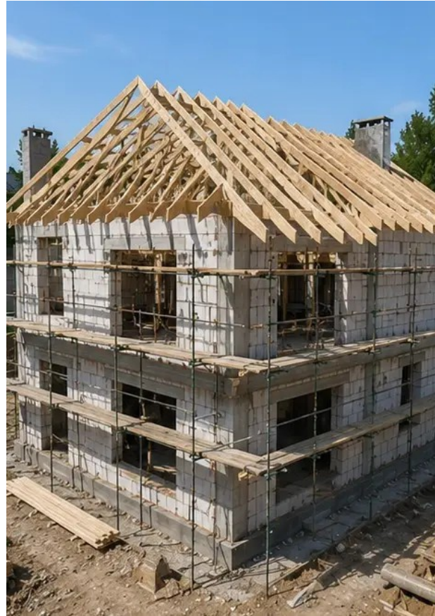
Ảnh số8 Công tác lắp mái hoàn tất
