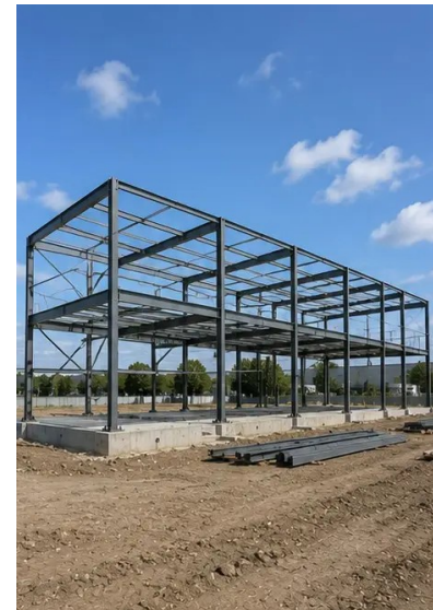
Ảnh số7. Thi công khung kết cấu đang tiến hành
