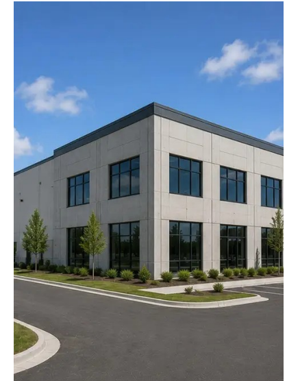
Ảnh số16. Dự án hoàn thiện sẵn sàng vận hành
