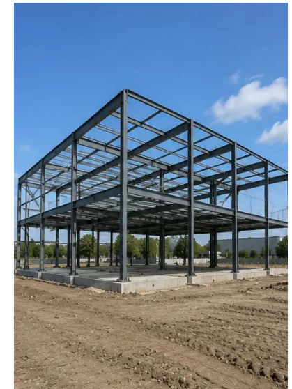
Ảnh số8. Khung kết cấu hoàn tất theo tiến độ dự án
