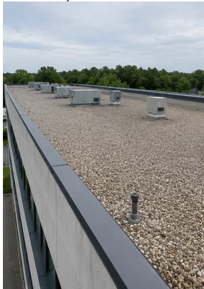
Photo #5. Kiểm tra tình trạng mái hoàn tất
