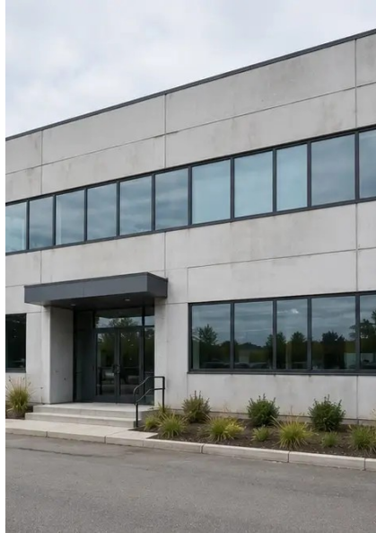
Photo #2. Tình trạng mặt tiền phía trước trong quá trình kiểm tra
