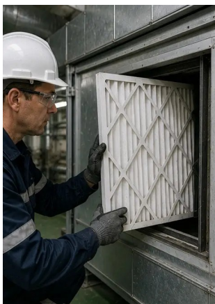
Ảnh số7. Thay thế bộ lọc khí hoàn tất
