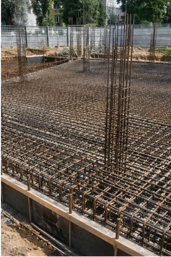
تصویر 4ء کنکریٹ ڈالنے سے پہلے ریبار کی تنصیب مکمل
