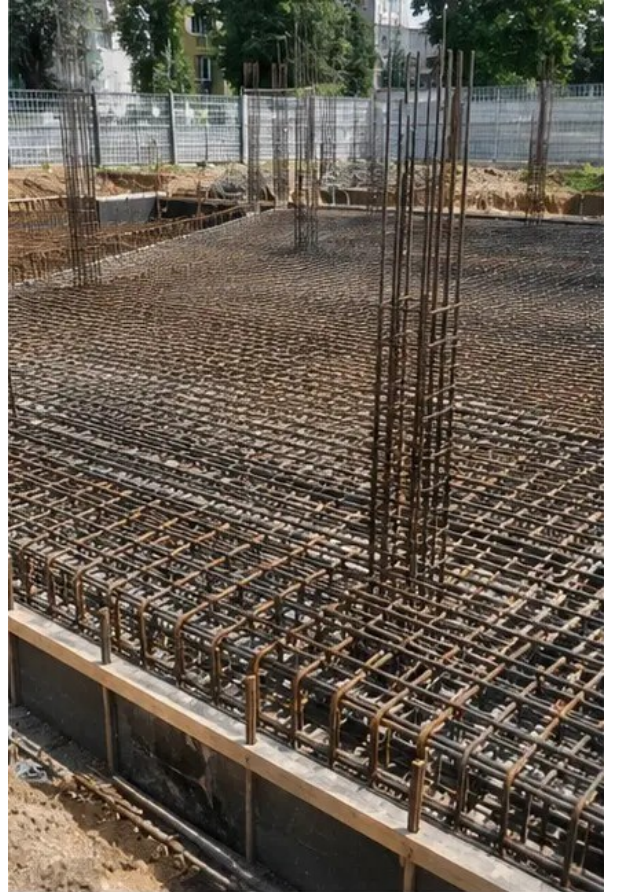
تصویر 4# کنکریٹ ڈالنے سے پہلے ریبار کی تنصیب مکمل
