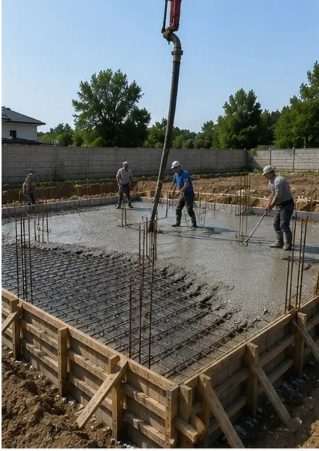
تصویر 5ء فاؤنڈیشن عناصر پر کنکریٹ ڈالنے کا عمل انجام دیا گیا
