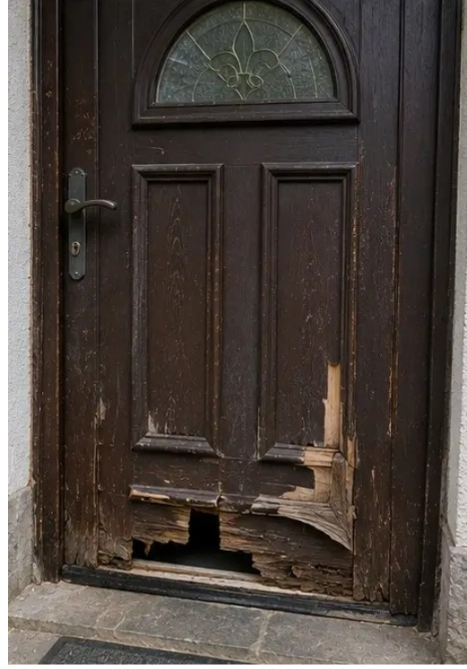
تصویر 8نہ معائنے کے دوران ریکارڈ کردہ خراب داخلی دروازہ
