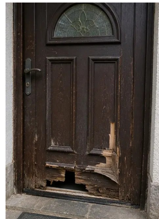
Photo #8. معائنے کے دوران ریکارڈ کردہ خراب داخلی دروازہ
