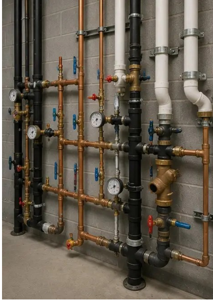
Photo #10. پلمبنگ سسٹم کا معائنہ مکمل
