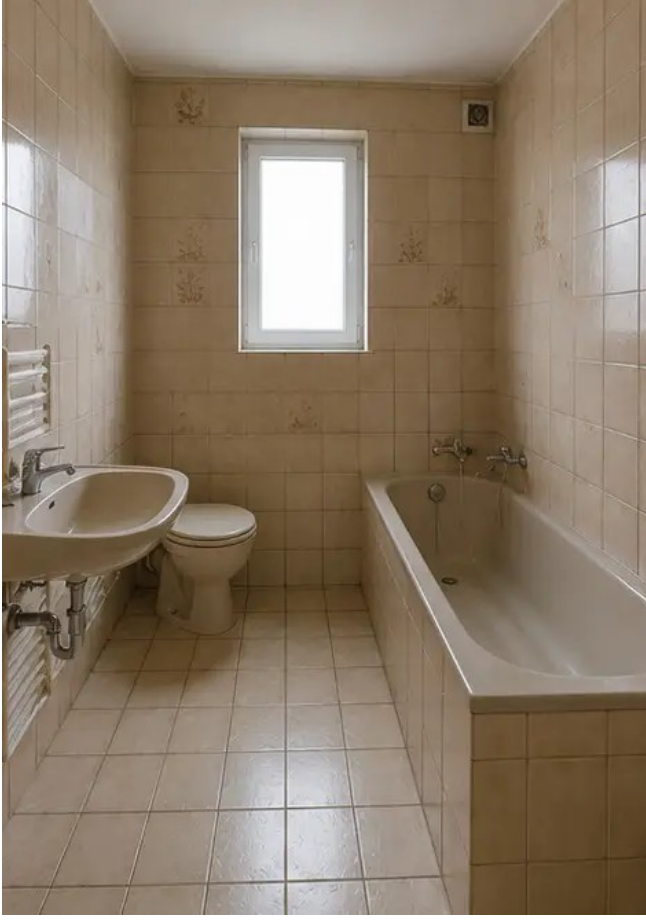
Görüntü No9 Yenileme öncesi banyo durumu
