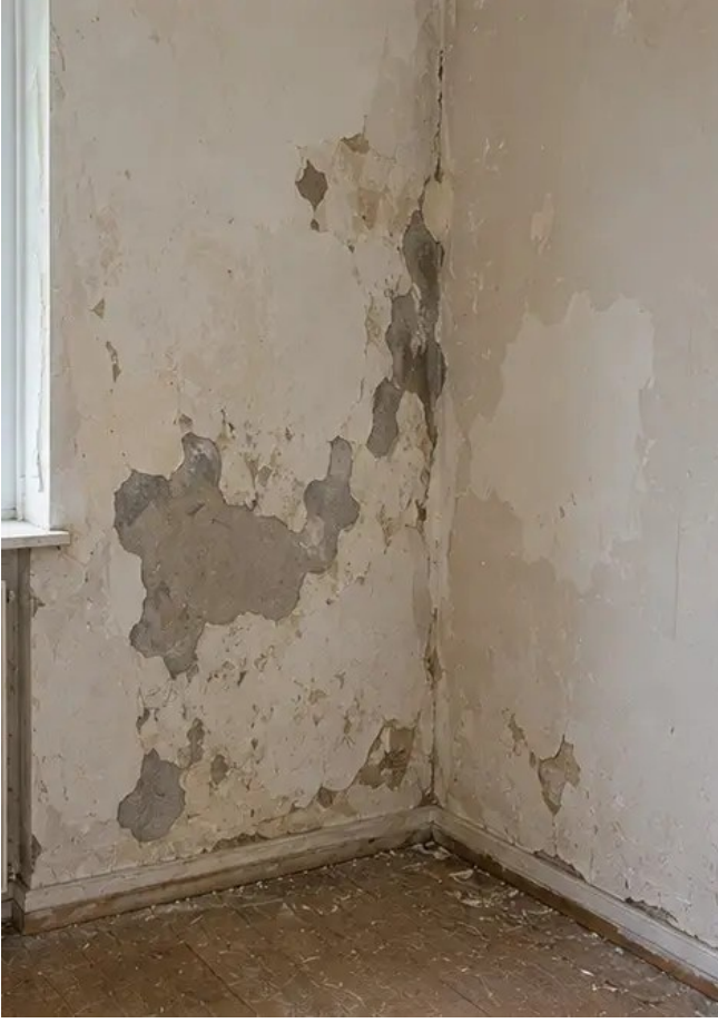
Görüntü No3 Onarım işleri öncesi duvar durumu
