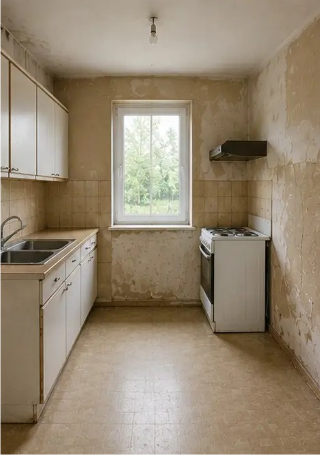
Görüntü No11 Yenileme öncesi mutfak durumu
