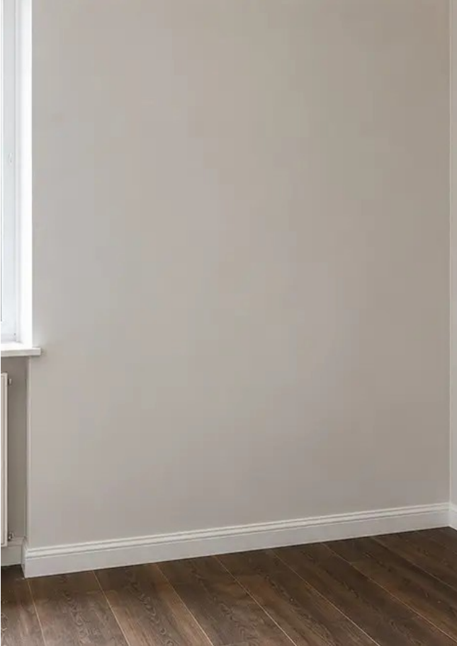
Görüntü No4 Onarım işleri sonrası duvar durumu
