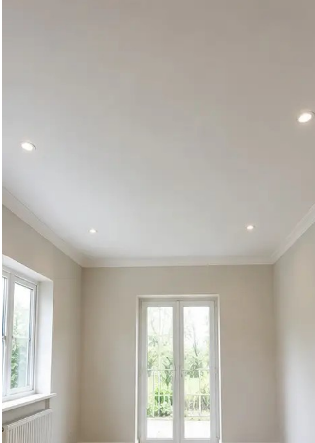
Görüntü No8 Yenileme sonrası tavan durumu
