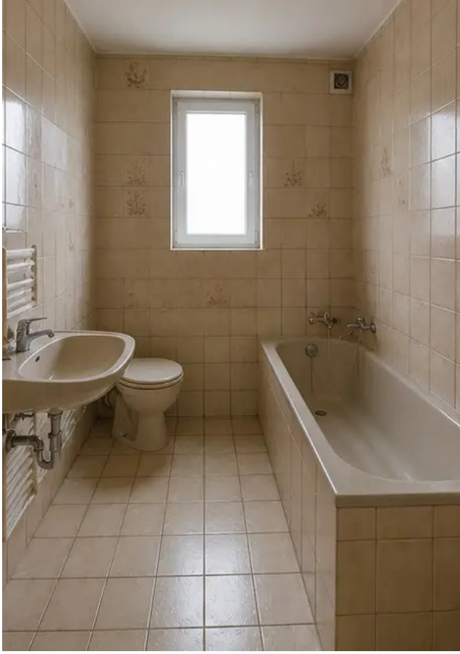
Görüntü No9 Yenileme öncesi banyo durumu
