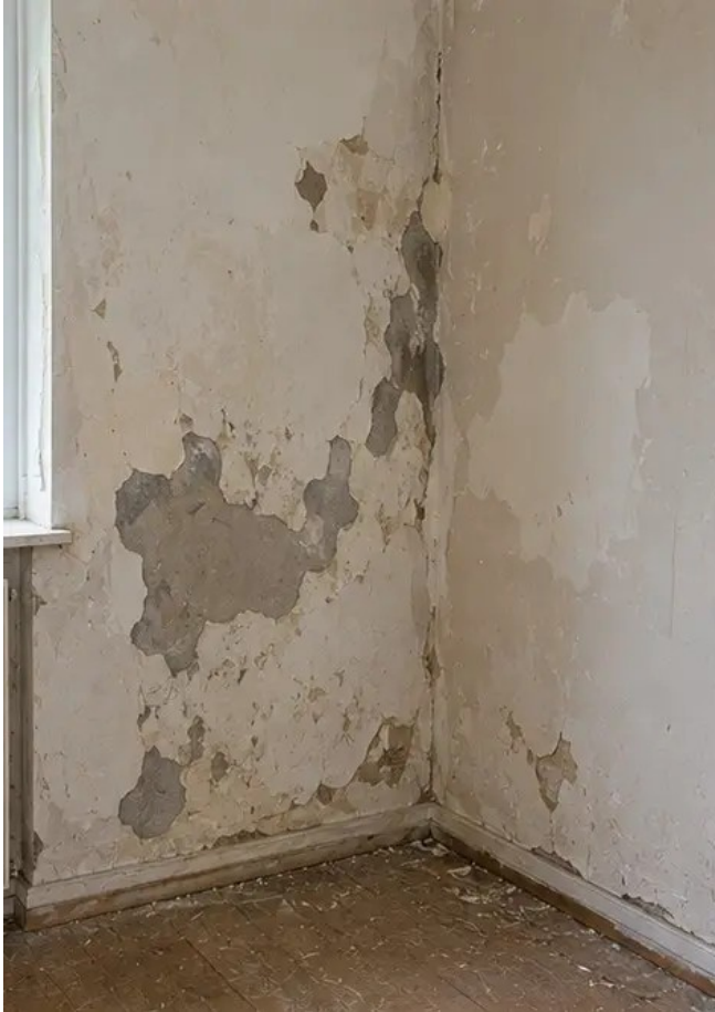
Görüntü No3 Onarım işleri öncesi duvar durumu
