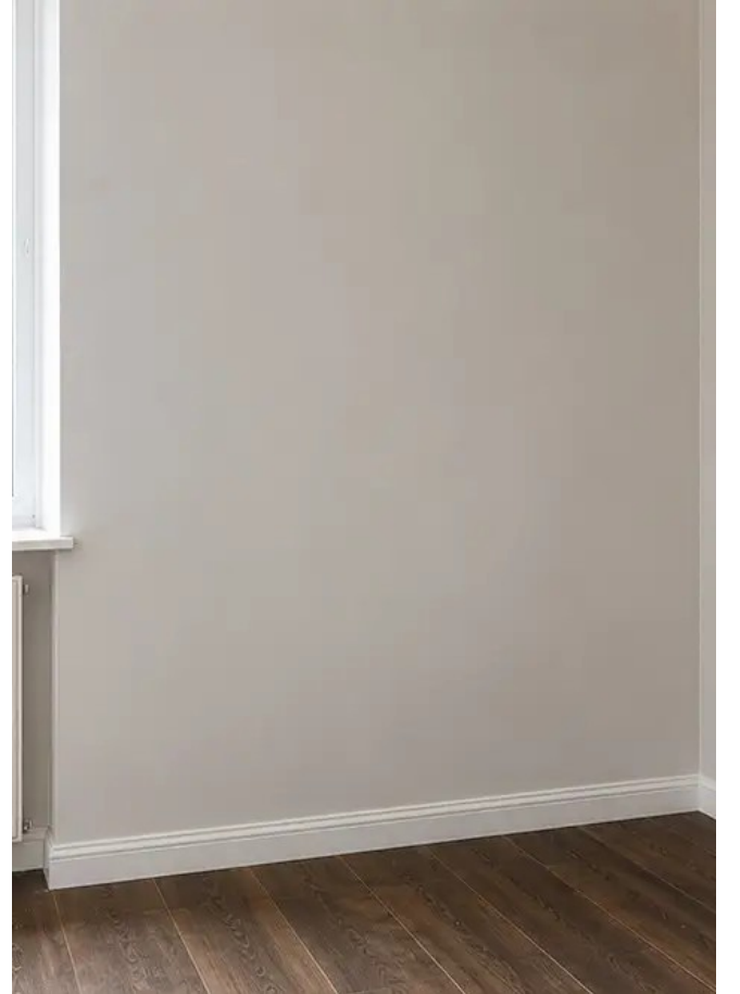
Görüntü No4 Onarım işleri sonrası duvar durumu
