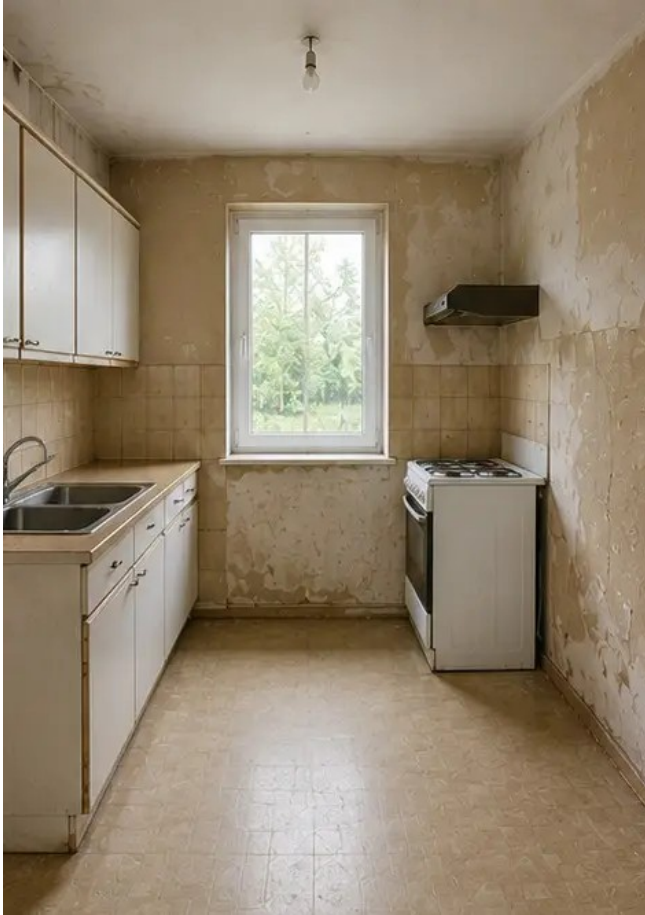
Görüntü No11 Yenileme öncesi mutfak durumu
