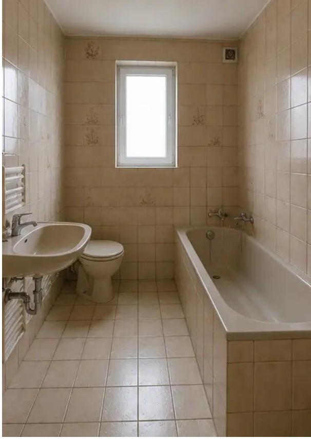
Görüntü No9 Yenileme öncesi banyo durumu
