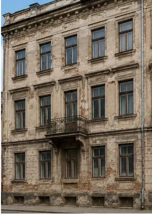
Görüntü No13 Restorasyon öncesi bina cephesi
