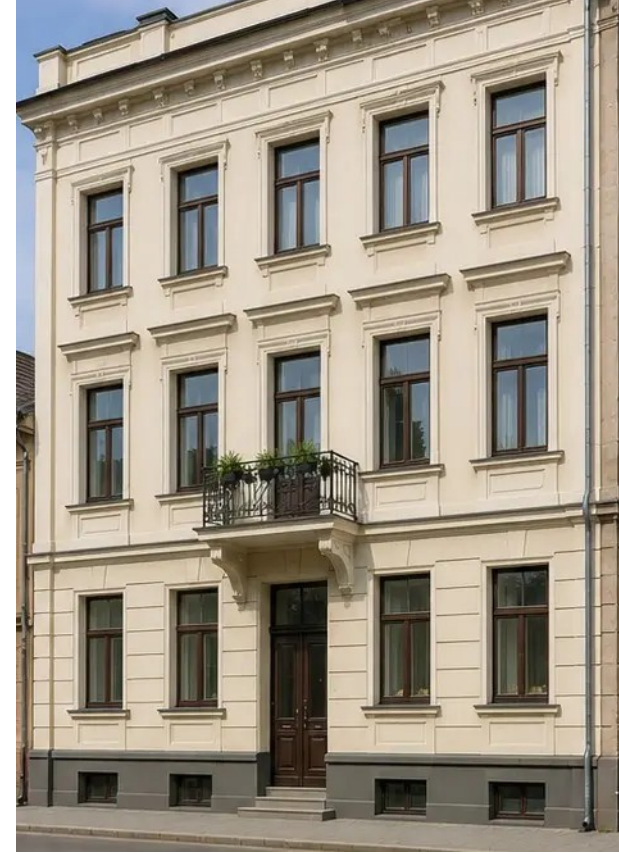
Görüntü No14 Restorasyon sonrası bina cephesi
