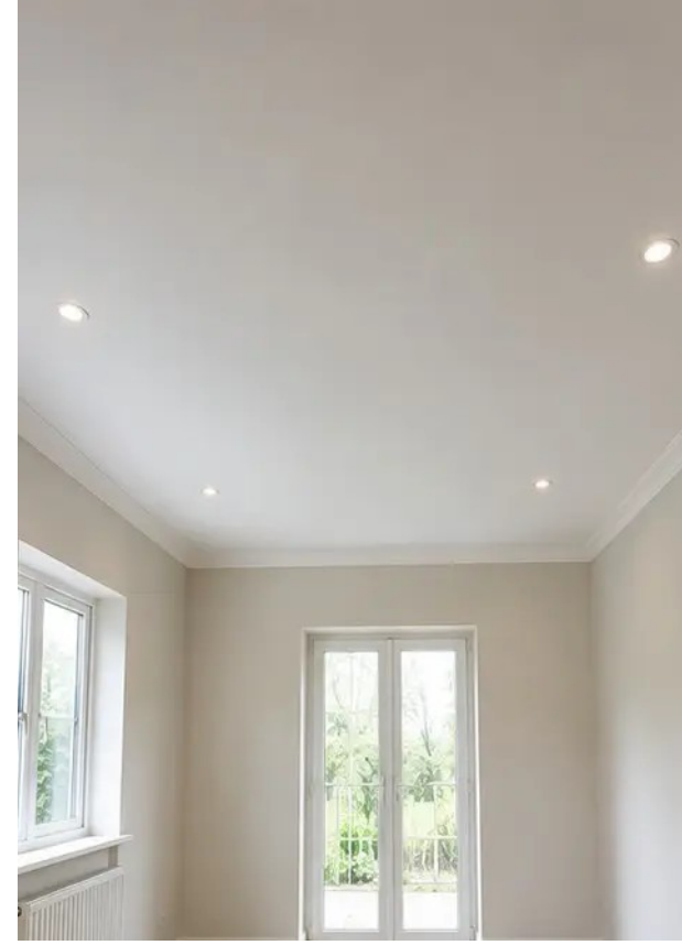
Görüntü No8 Yenileme sonrası tavan durumu
