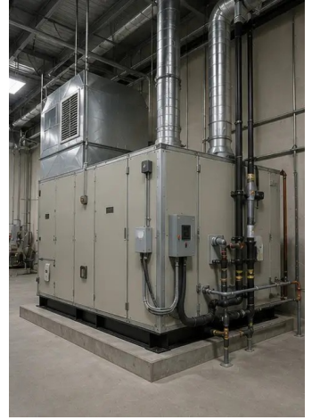
Görüntü No14. Ekipman montajı tamamlandı
