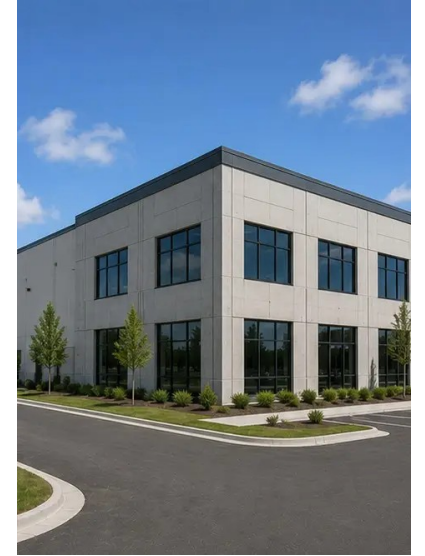
Görüntü No16. Tamamlanmış proje işletmeye hazır
