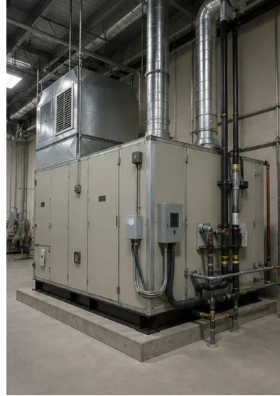
Görüntü No14. Ekipman montajı tamamlandı
