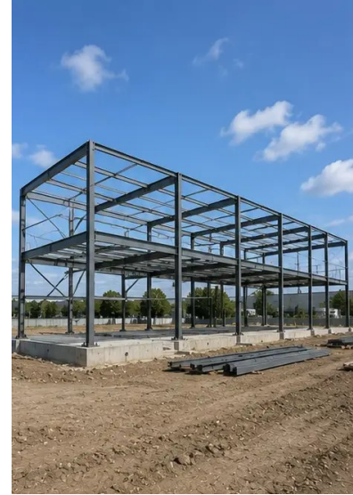
Görüntü No7. Taşıyıcı sistem inşaatı devam ediyor
