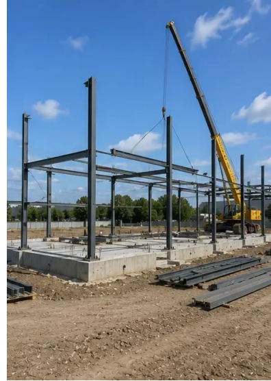
Görüntü No6. Taşıyıcı sistem montajı başladı
