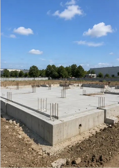
Görüntü No5. Temel inşaatı tamamlandı
