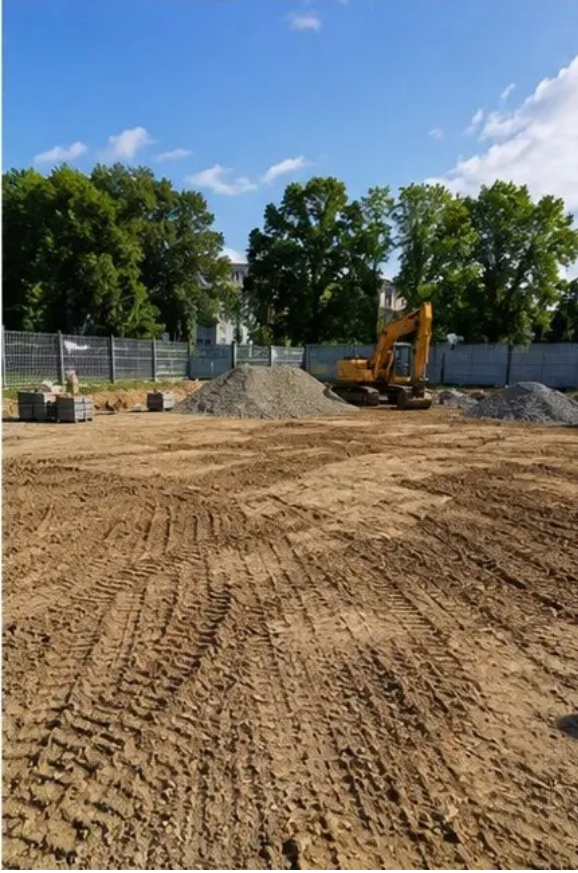
Görüntü No1 İnşaata başlamadan önce şantiye hazırlık çalışmaları tamamlandı
