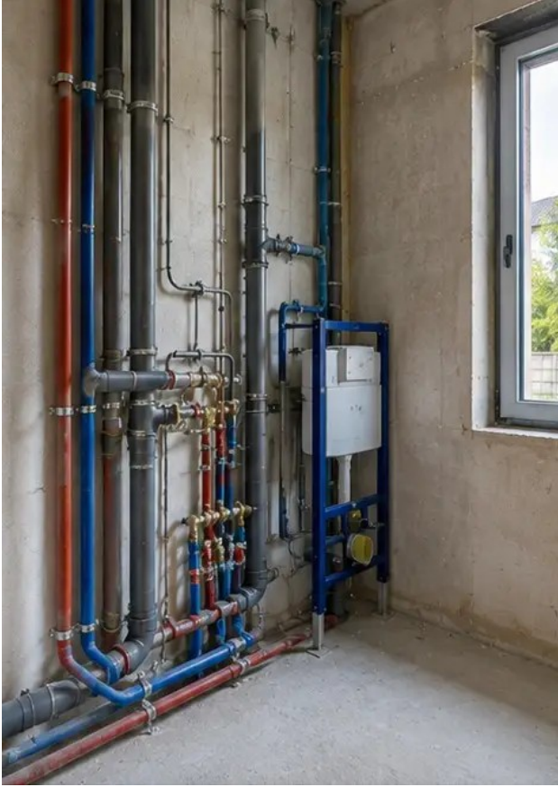
Görüntü No10 Belirlenen alanlarda sıhhi tesisat sistemleri montajı tamamlandı
