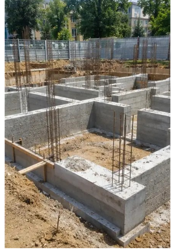
Görüntü No3 Temel inşaatı devam ediyor
