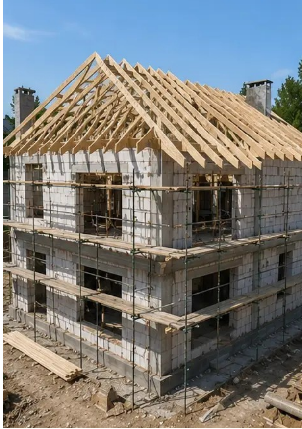
Görüntü No8 Çatı montaj işleri tamamlandı
