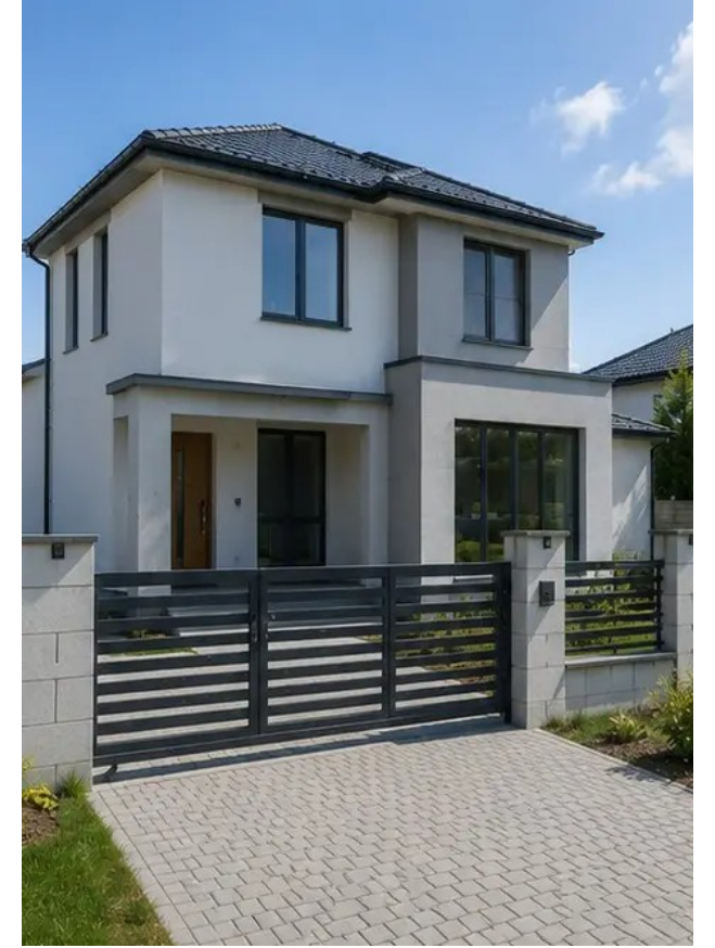
Görüntü No15 İnşaat sonrası tamamlanmış bina dış cephesi
