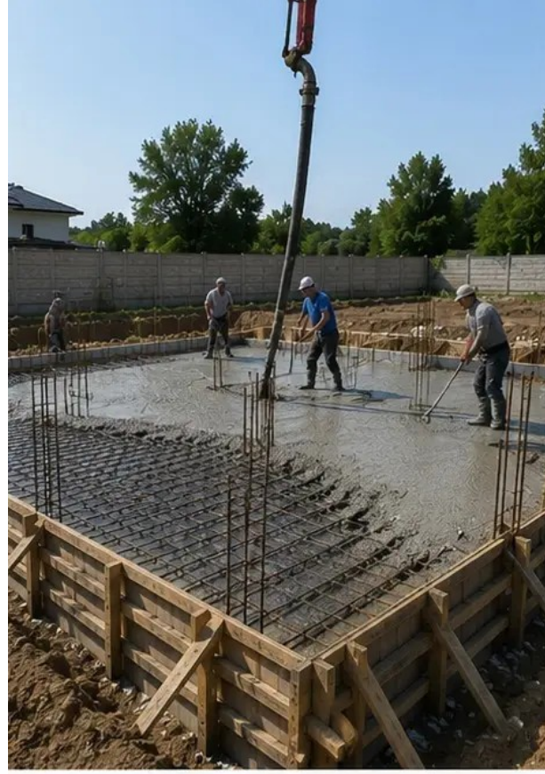
Görüntü No5 Temel elemanlarına beton dökümü işlemi yapıldı
