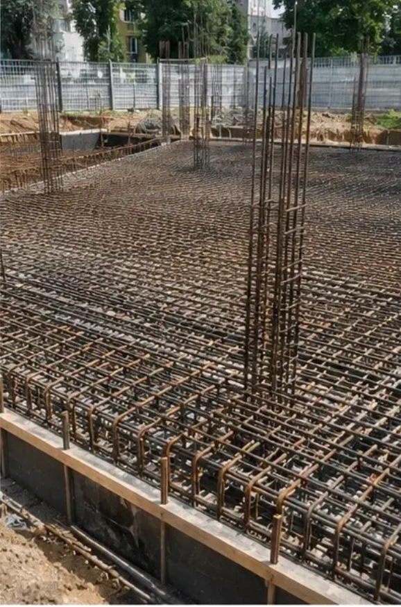
Görüntü No4 Beton dökümünden önce donatı montajı tamamlandı
