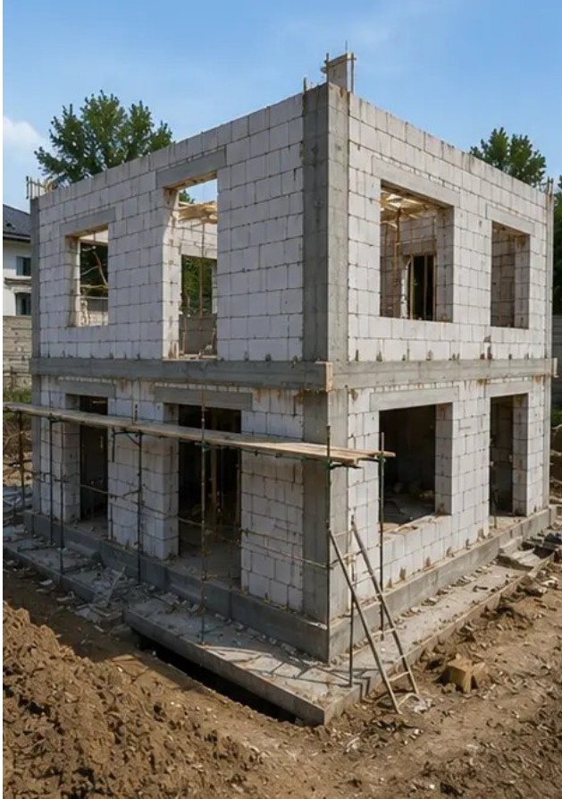
Görüntü No7 Bina bölümü için dış duvar inşaatı tamamlandı
