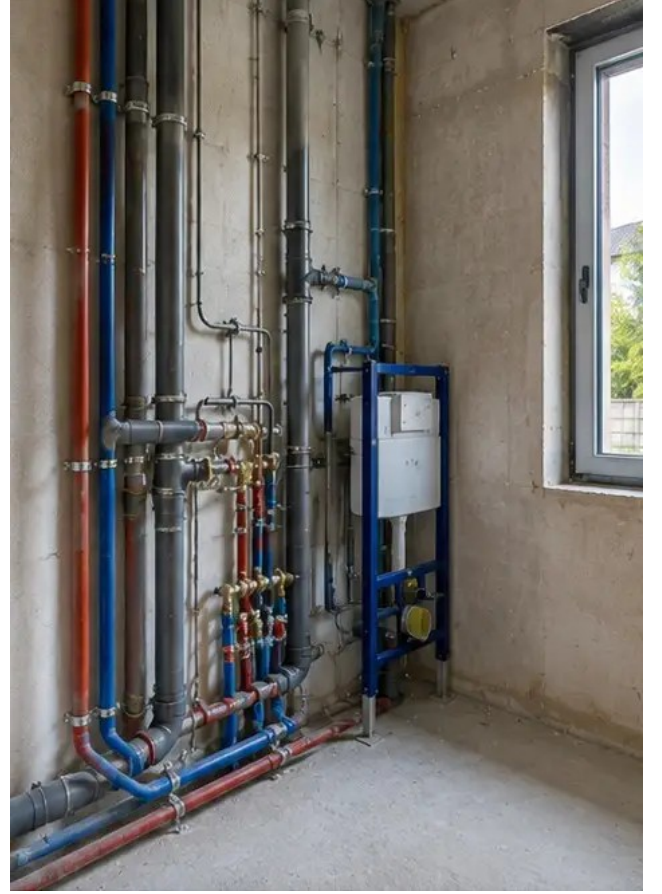
Görüntü No10 Belirlenen alanlarda sıhhi tesisat sistemleri montajı tamamlandı
