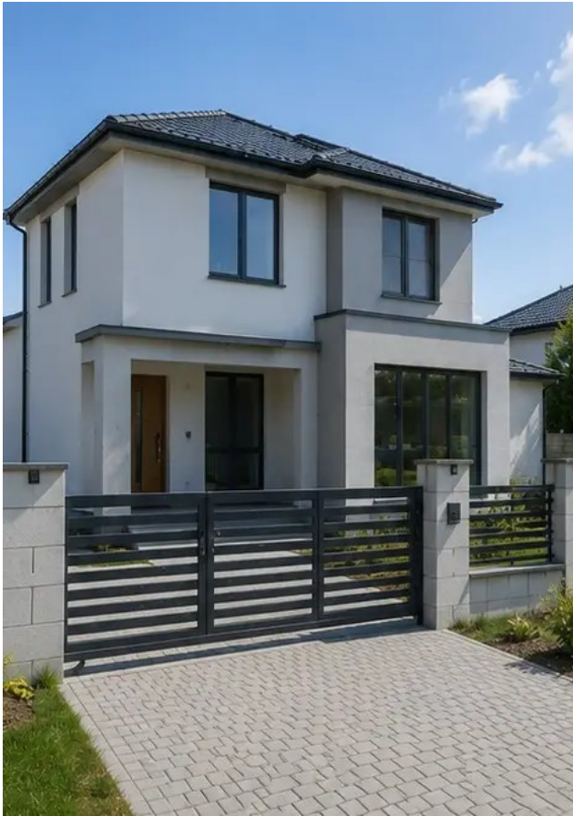
Görüntü No15 İnşaat sonrası tamamlanmış bina dış cephesi
