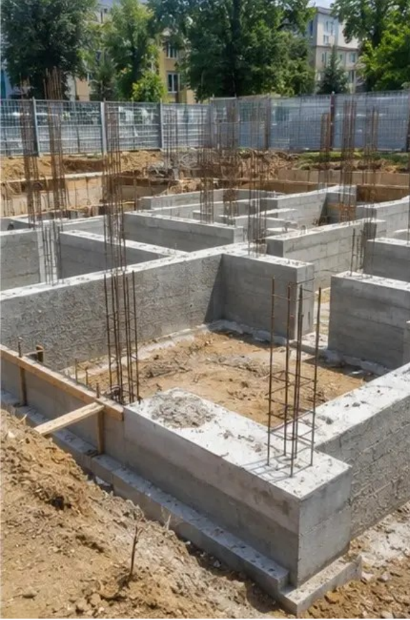
Görüntü No3 Temel inşaatı devam ediyor
