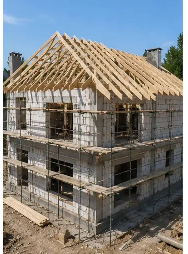
Görüntü No8 Çatı montaj işleri tamamlandı
