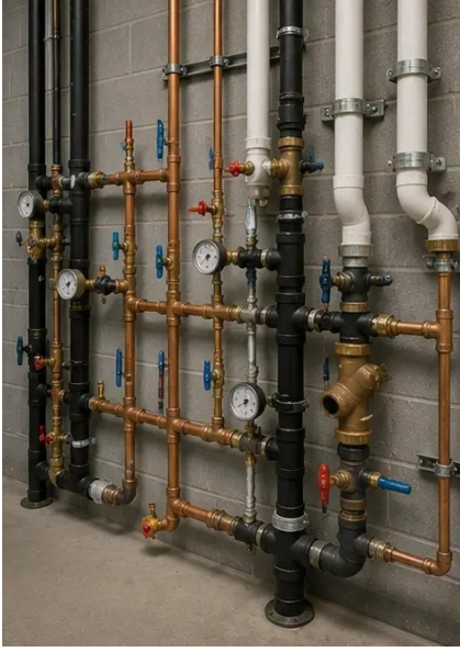
Photo #10. Sıhhi tesisat sistemi denetimi tamamlandı
