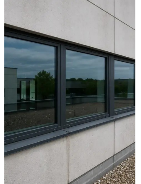
Photo #6. Denetim sırasında belgelenen pencere durumu
