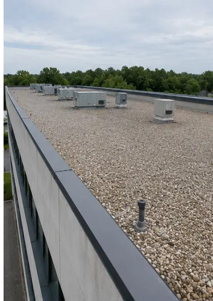
Photo #5. Çatı durum denetimi tamamlandı
