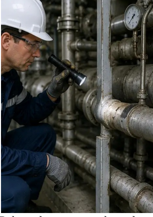
Görüntü No9. Bakım planına uygun boru denetimi tamamlandı
