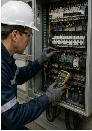
Görüntü No5. Elektrik panosu denetimi yapıldı
