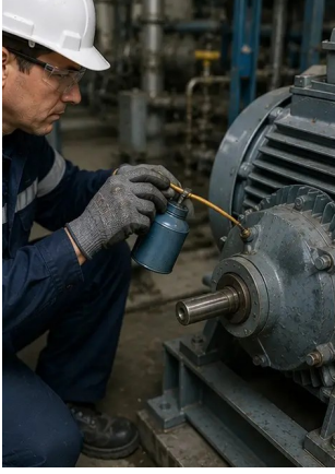
Görüntü No11. Ekipman bileşenlerine yağlama çalışmaları yapıldı
