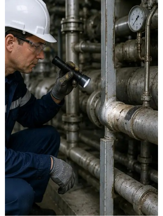
Görüntü No9. Bakım planına uygun boru denetimi tamamlandı
