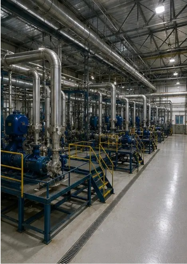
Görüntü No16. Bakım çalışmalarının tamamlanmasından sonra tesis genel görünümü
