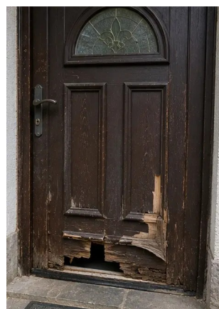
Photo #8. ประตูทางเข้าที่เสียหายบันทึกระหว่างการตรวจสอบ
