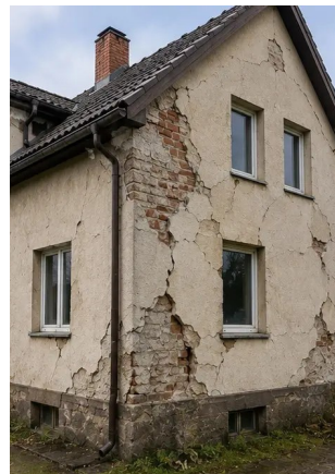
Photo #2. ภาพรวมความเสียหายภายนอกที่บันทึกระหว่างการตรวจสอบ
