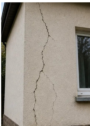
Photo #5. รอยร้าวในผนังโครงสร้างบันทึกระหว่างการตรวจสอบ
