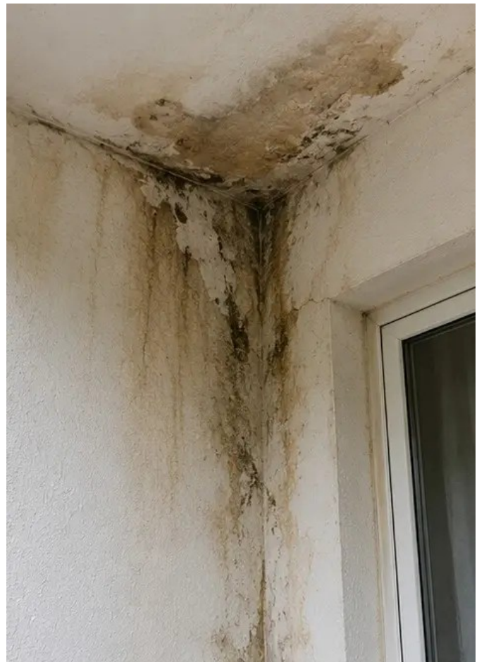
รูปภาพ №6 พื้นที่ความเสียหายจากน้ำระบุและบันทึกแล้ว
