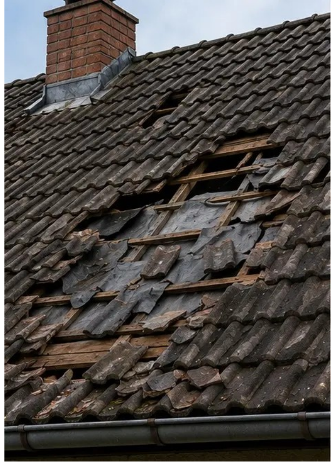
รูปภาพ №3 พื้นที่หลังคาที่เสียหายระบุดและบันทึกลงแล้ว
