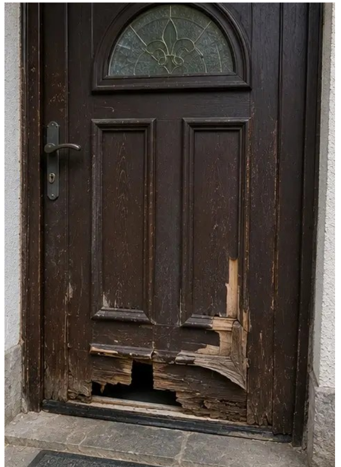
รูปภาพ №8 ประตูทางเข้าที่เสียหายบันทึกระหว่างการตรวจสอบ
