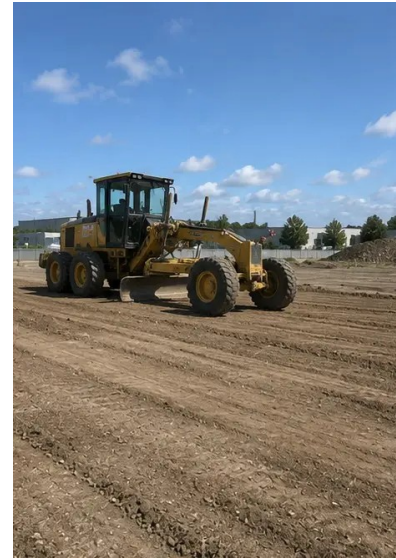
รูปภาพ №3. การเคลียร์และปรับระดับดินเสร็จ
