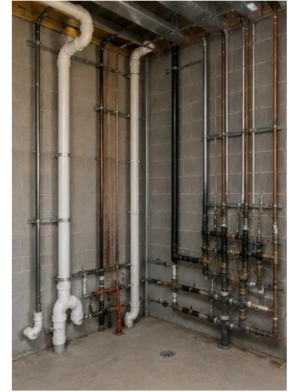
รูปภาพ №12. ติดตั้งระบบประปาเสร็จ
