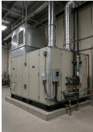
รูปภาพ №14. ติดตั้งอุปกรณ์เสร็จ
