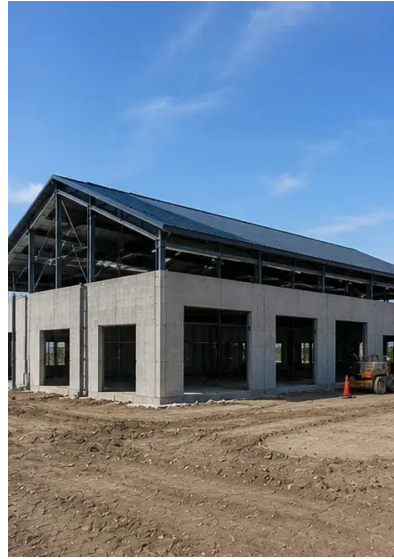
รูปภาพ №10. ก่อสร้างหลังคาเสร็จ
