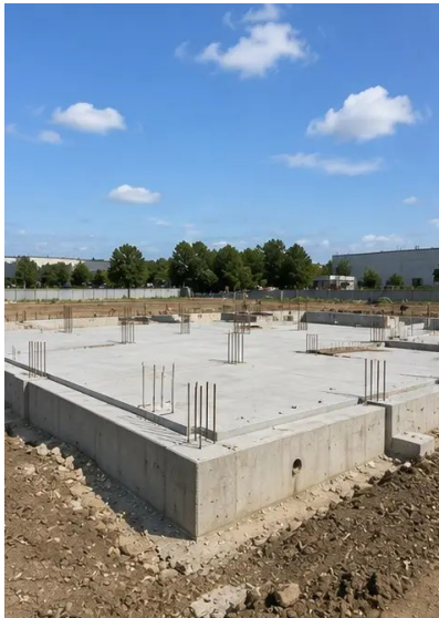
รูปภาพ №5. ก่อสร้างฐานรากเสร็จ
