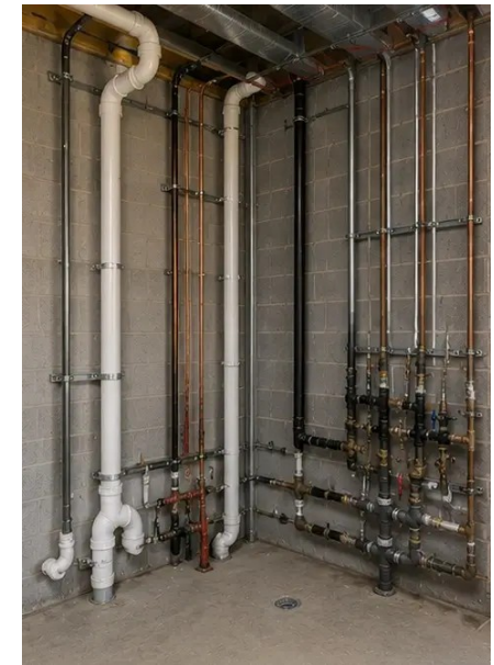
รูปภาพ №16. โครงการที่แล้วเสร็จพร้อมดำเนินการ
