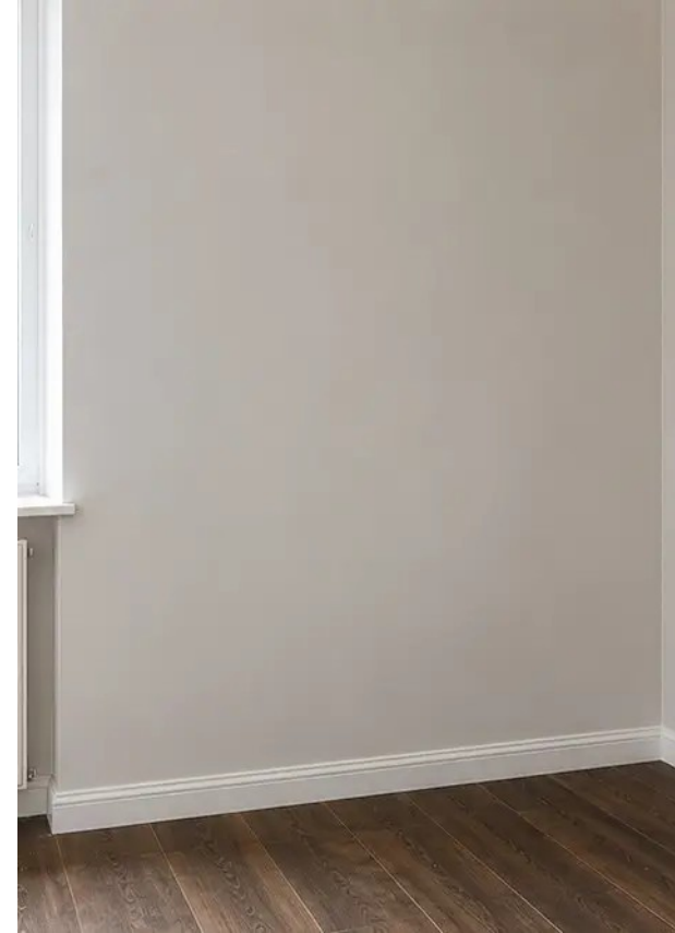
รูปภาพ №4 สภาพผนังหลังงานซ่อมแซม
