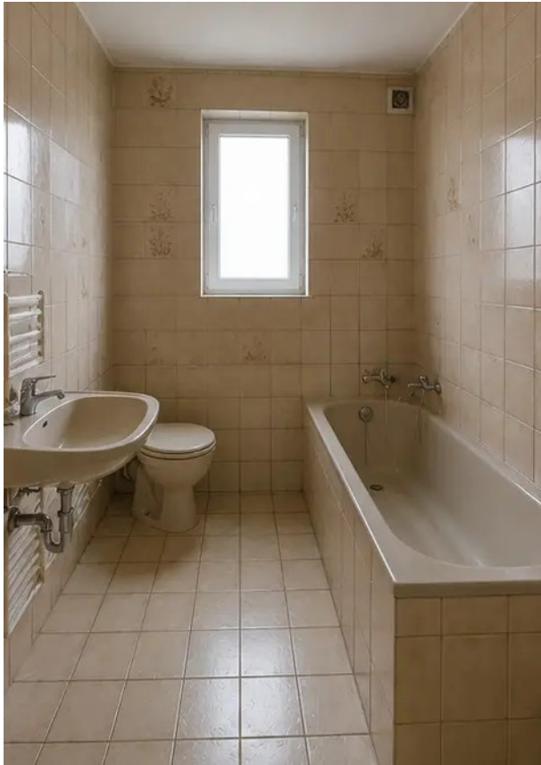
รูปภาพ №9 สภาพห้องน้ำก่อนการปรับปรุง
