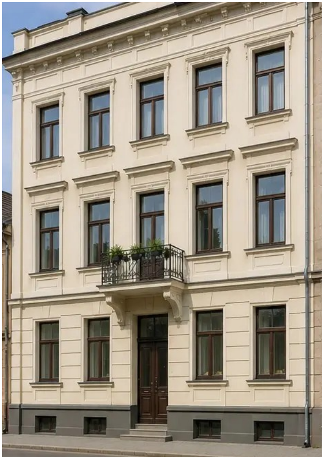
รูปภาพ №14 ด้านหน้าอาคารหลังงานบูรณะ
