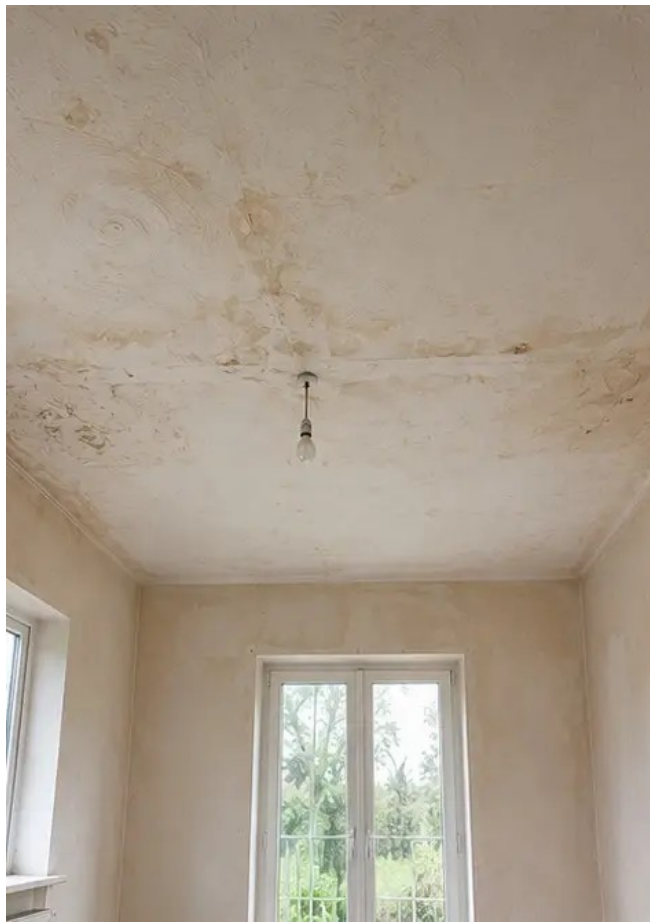
รูปภาพ №7 สภาพฝ้าเพดานก่อนการปรับปรุง
