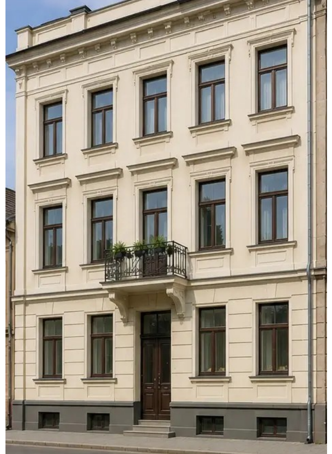
รูปภาพ №14 ด้านหน้าอาคารหลังงานบูรณะ
