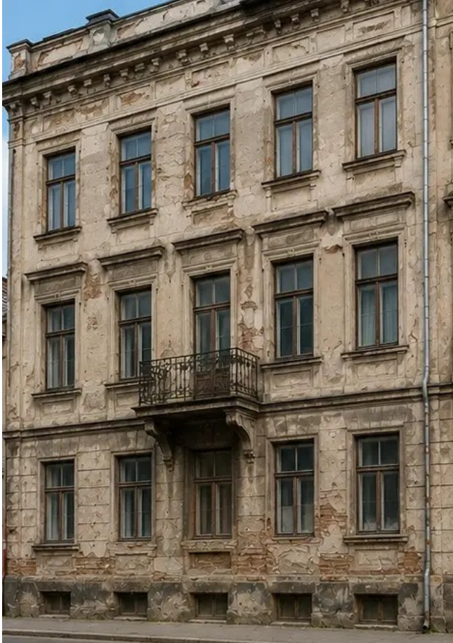
รูปภาพ №13 ด้านหน้าอาคารก่อนงานบูรณะ
