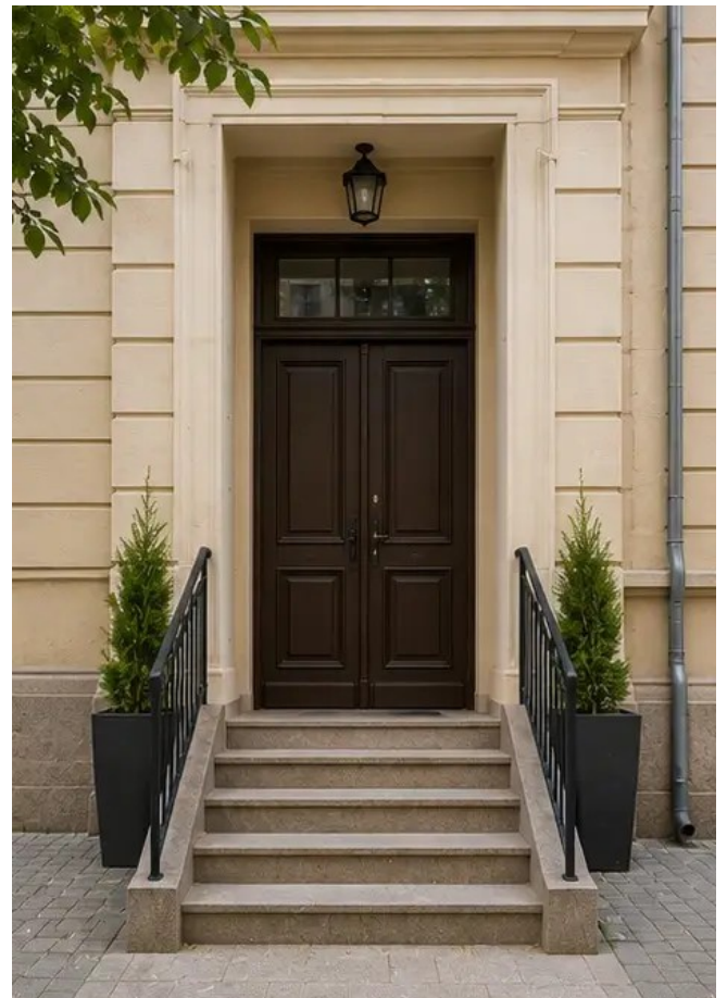
รูปภาพ №16 Property entrance after improvement
