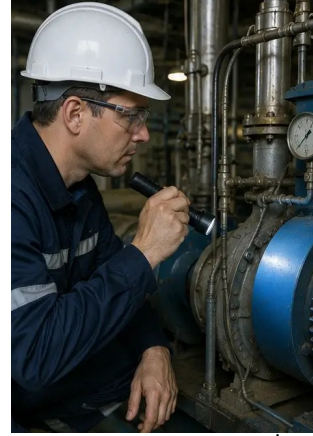
รูปภาพ №2. ตรวจสอบอุปกรณ์เครื่องกลเสร็จ
