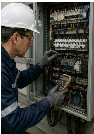
รูปภาพ №5. ตรวจสอบตู้ไฟฟ้าดำเนินการแล้ว
