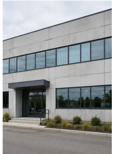
Photo #2. สภาพด้านหน้าอาคารระหว่างการตรวจสอบ
