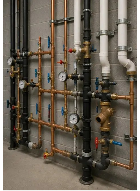
Photo #10. ตรวจสอบระบบประปาเสร็จ
