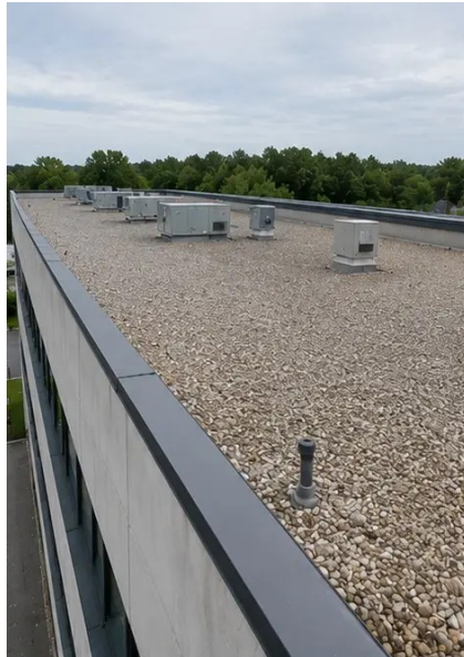
Photo #5. ตรวจสอบสภาพหลังคาเสร็จ
