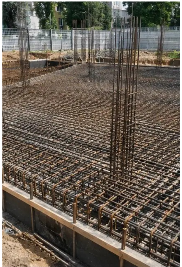
รูปภาพ №4 ติดตั้งเหล็กเสริมเสร็จก่อนเทคอนกรีต
