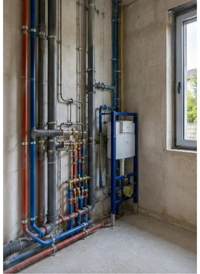
รูปภาพ №10 ติดตั้งระบบประปาเสร็จในพื้นที่ที่กำหนด
