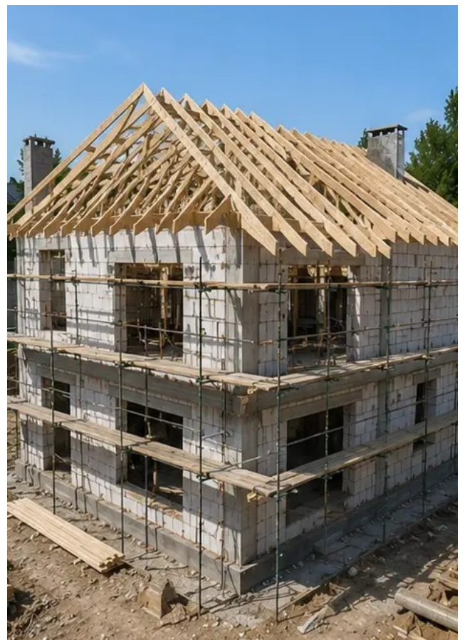
รูปภาพ №8 งานติดตั้งหลังคาเสร็จ
