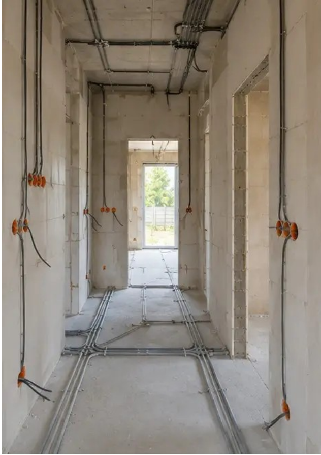
รูปภาพ №9 ติดตั้งระบบไฟฟ้ากำลังดำเนินการ
