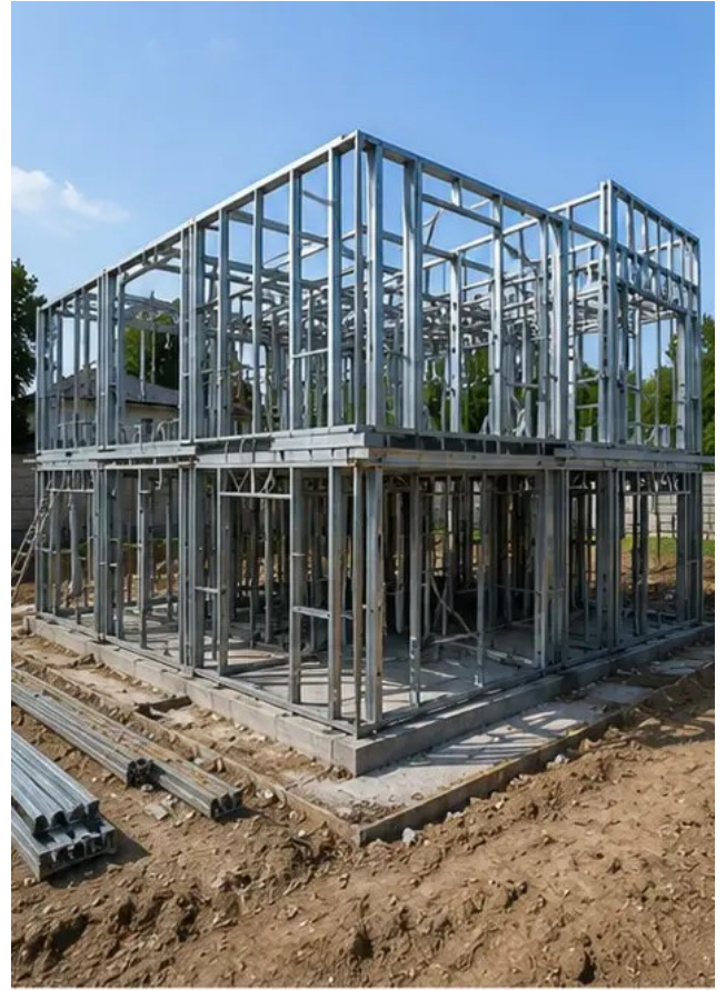
รูปภาพ №6 การประกอบโครงสร้างกำลังดำเนินการ
