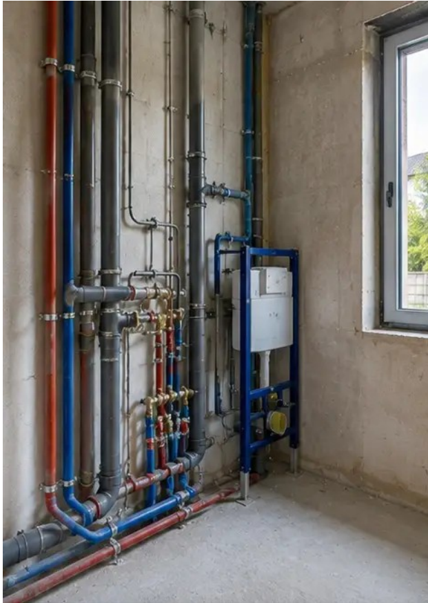
รูปภาพ №10 ติดตั้งระบบประปาเสร็จในพื้นที่ที่กำหนด
