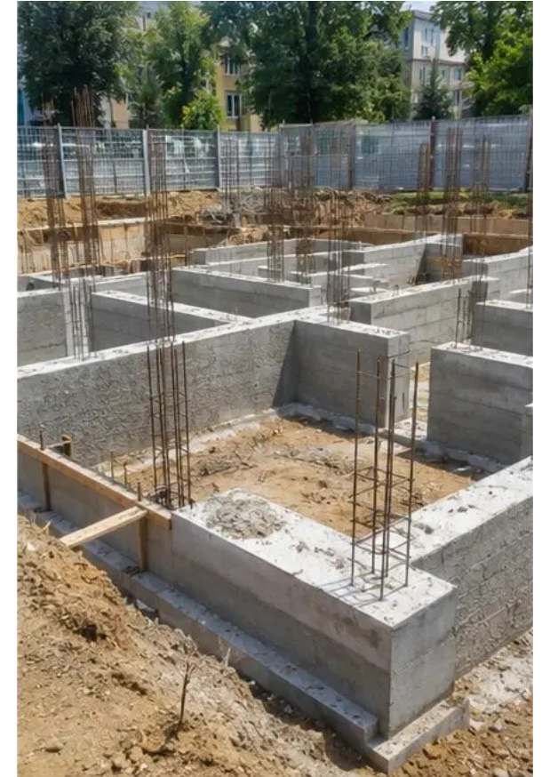
รูปภาพ №3 งานก่อสร้างฐานรากกำลังดำเนินการ
