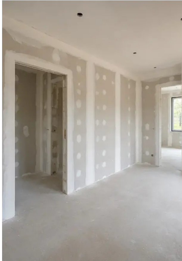
รูปภาพ №11 งานตกแต่งผนังภายในกำลังดำเนินการ
