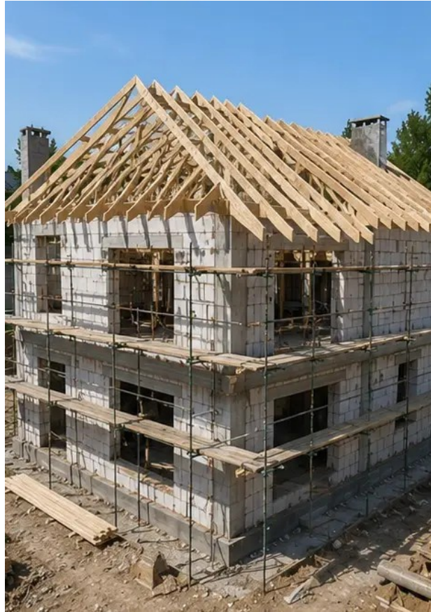
รูปภาพ №8 งานติดตั้งหลังคาเสร็จ
