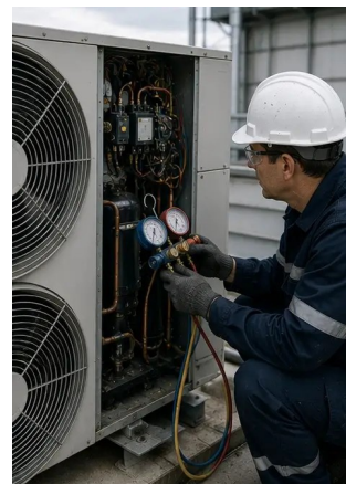
Fotografi nr6. VVS-utrustningens skick dokumenterat
