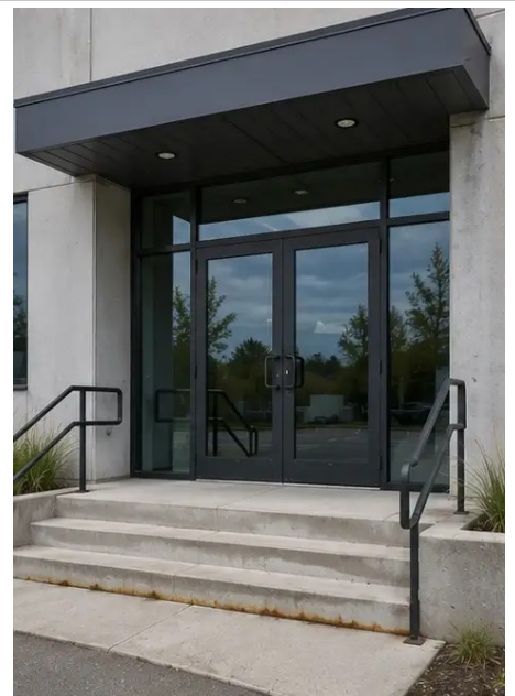
Photo #3. Huvudentréområde besiktigat och dokumenterat
