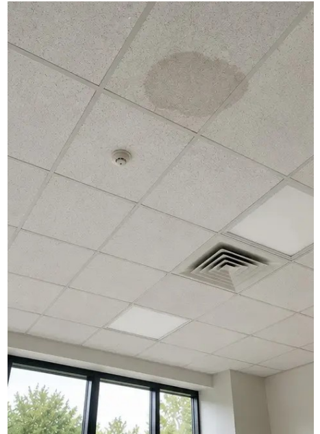
Photo #13. Takets skick dokumenterat under besiktning
