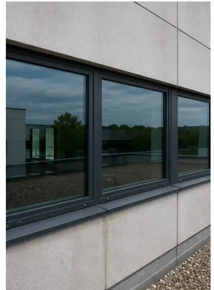
Photo #6. Fönstrens skick dokumenterat under besiktning
