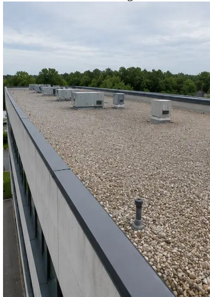
Photo #5. Takbesiktning slutförd
