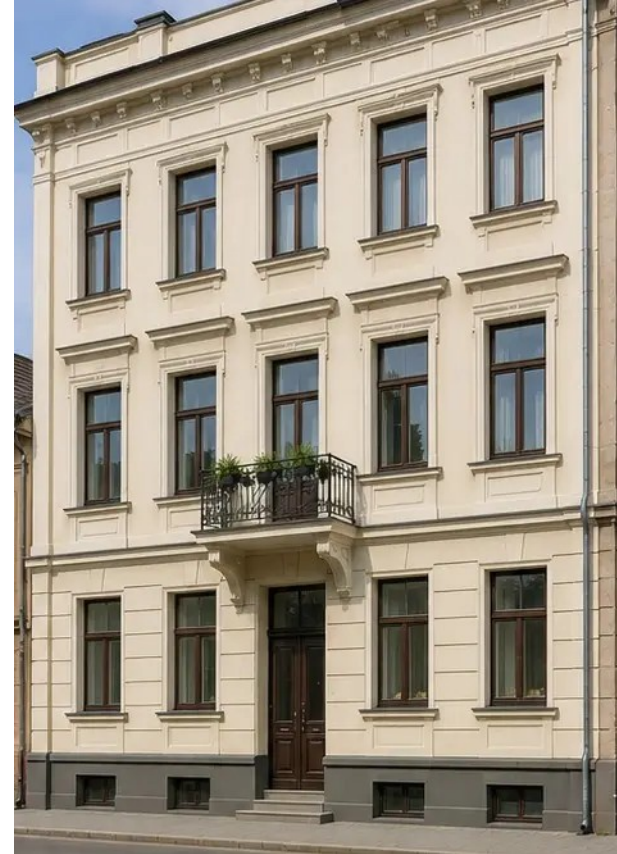
Fotografi nr14 Byggnadens fasad efter restaureringsarbeten
