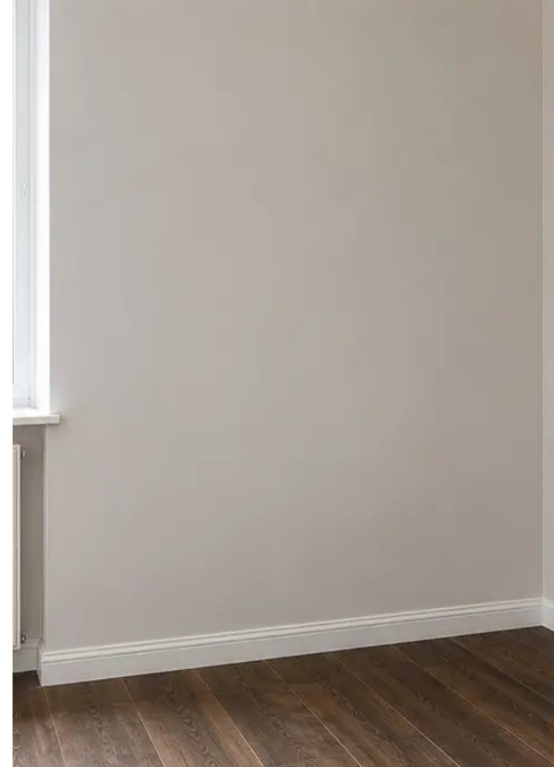
Fotografi nr4 Väggens skick efter reparationsarbete
