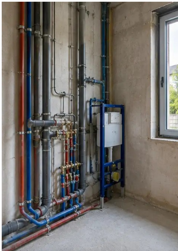
Fotografi nr10 VVS-systeminstallation slutförd i angivna områden
