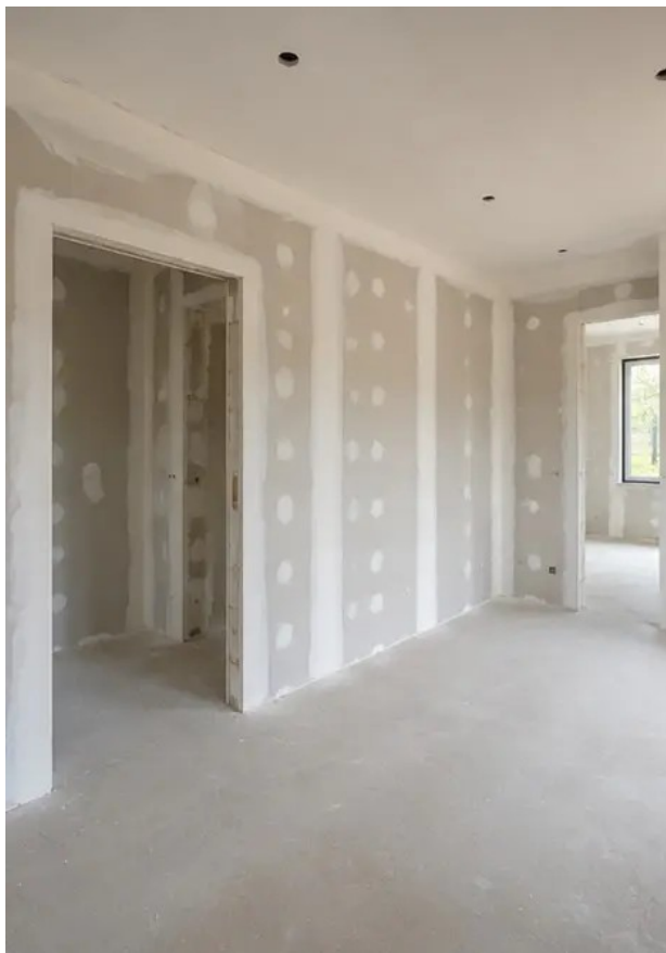
Fotografi nr11 Invändig väggfinish pågår
