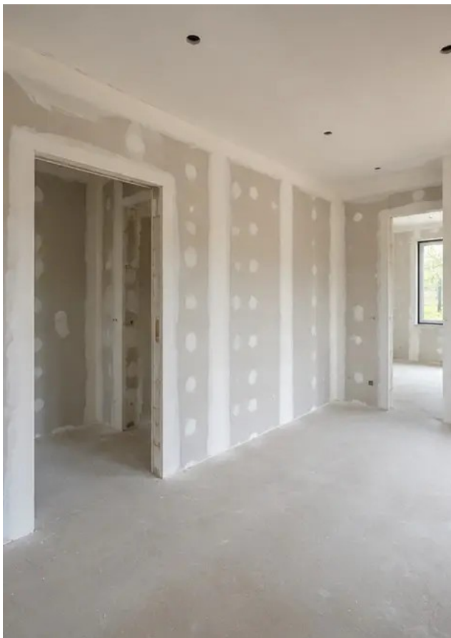
Fotografi nr11 Invändig väggfinish pågår
