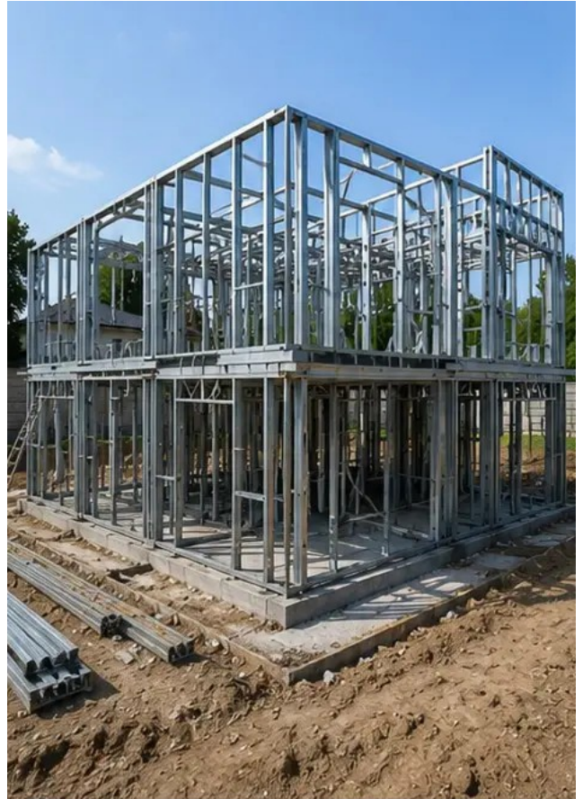
Fotografi nr6 Montering av bärande stomme pågår
