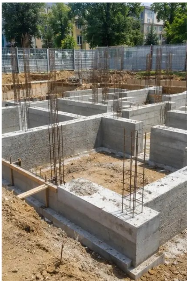
Fotografi nr3 Grundläggning pågår
