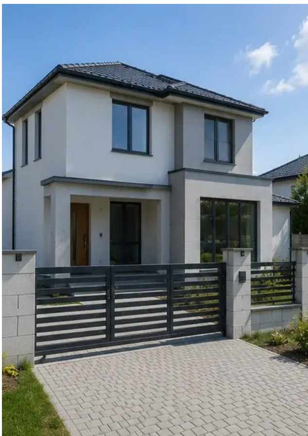
Fotografi nr15 Färdigställd byggnadsexteriör efter byggnation
