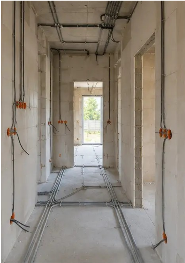
Fotografi nr9 Elsysteminstallation pågår
