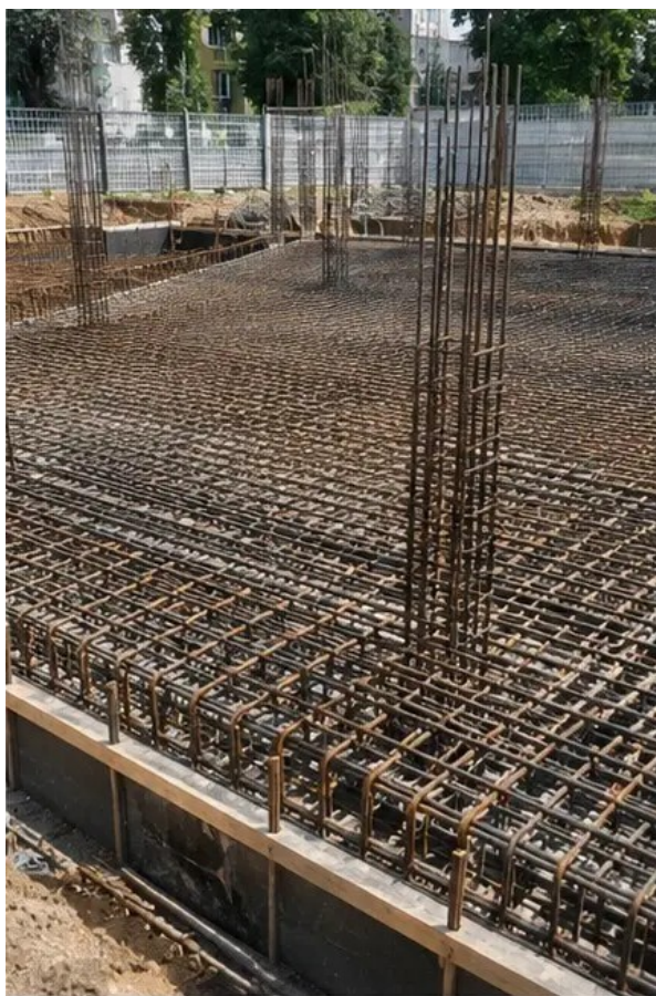
Fotografi nr4 Armering monterad före betonggjutning
