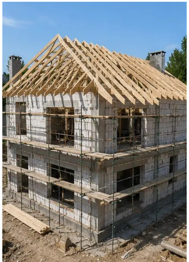
Fotografi nr8 Takinstallationsarbeten slutförda
