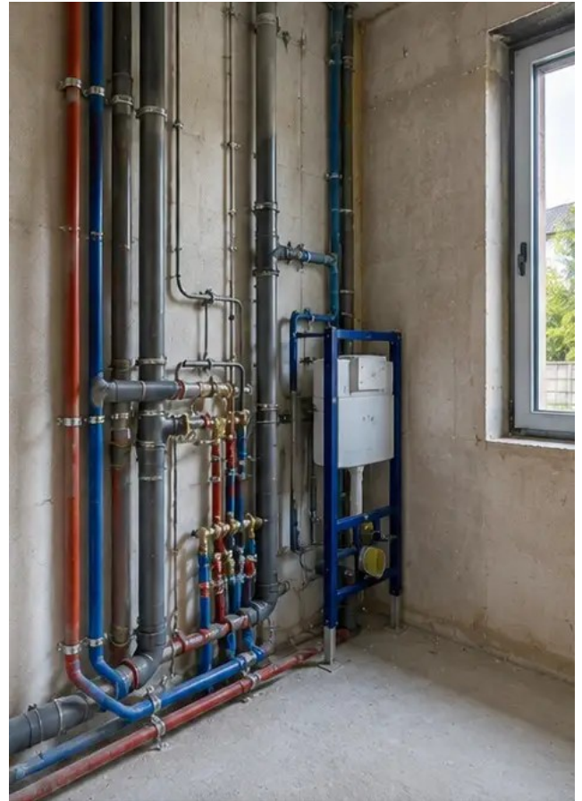
Fotografi nr10 VVS-systeminstallation slutförd i angivna områden
