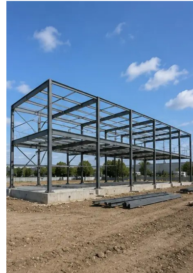
Fotografi nr7. Byggnation av bärande stomme pågår
