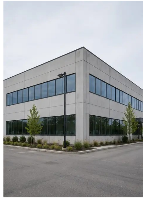
Photo #1. Општи поглед на прегледану некретнину
