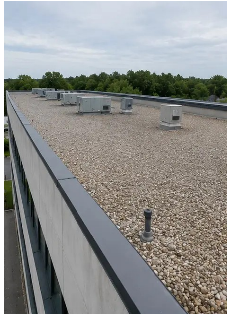
Photo #5. Преглед стања крова завршен
