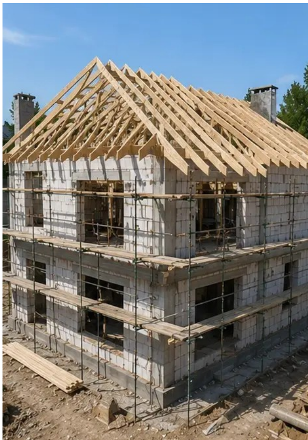
Слика бр.8 Радови на постављању крова завршени
