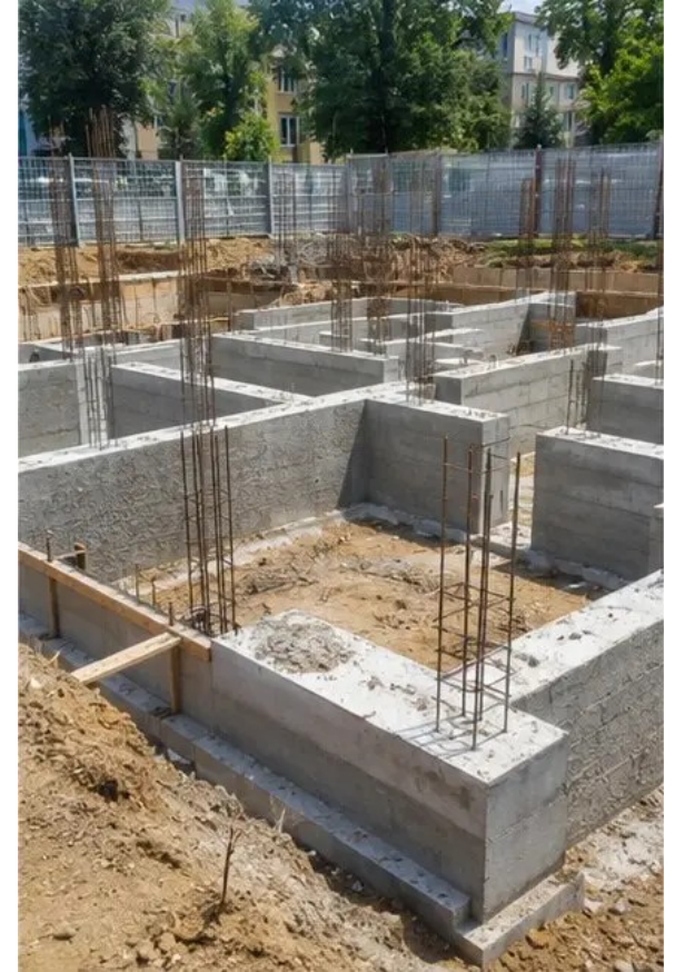
Слика бр.3 Изградња темеља у току
