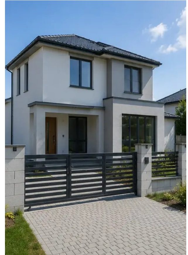
Слика бр.15 Завршена спољашњост зграде након изградње
